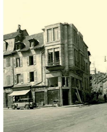
La pharmacie en construction en 1934 © TOUS DROITS RÉSERVÉS
