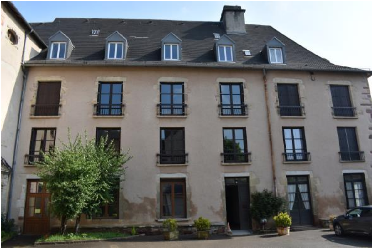
Figure 19 : partie F, élévation du logis principal donnant sur la cour, vue depuis le sud.
