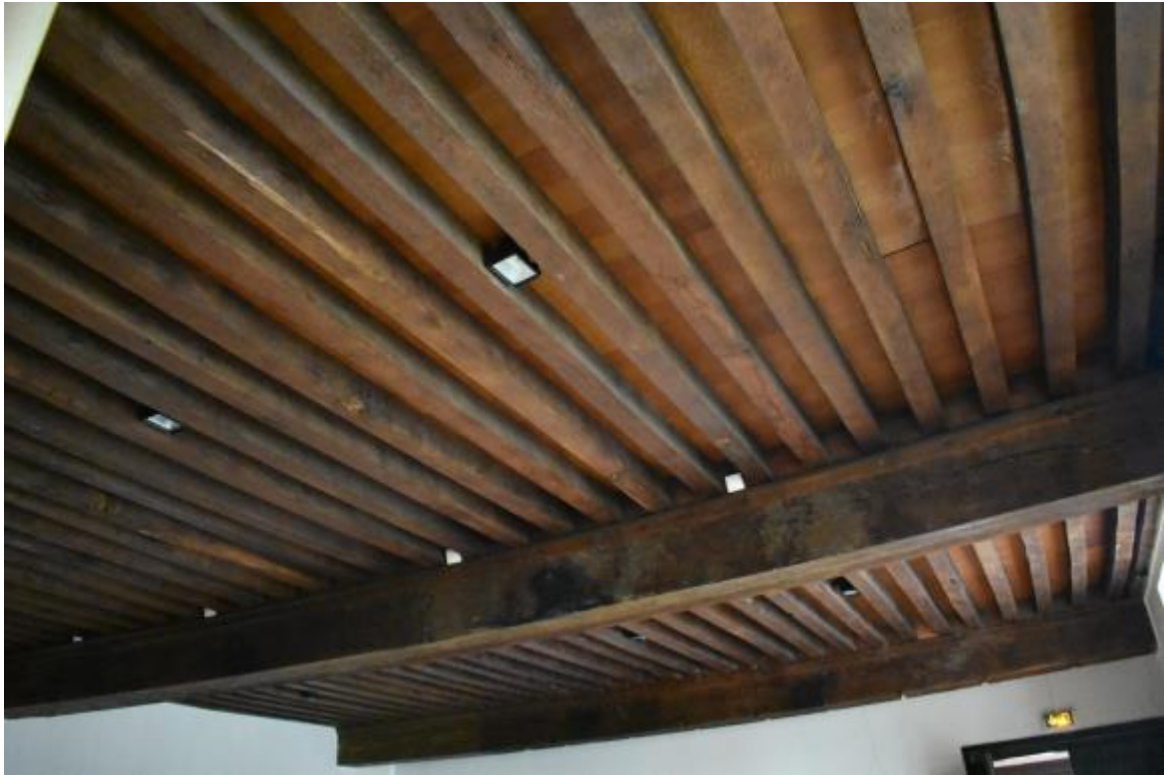
Figure 21 : partie ouest de la portion F, plafond à la française au rez-de-chaussée du logis principal.
