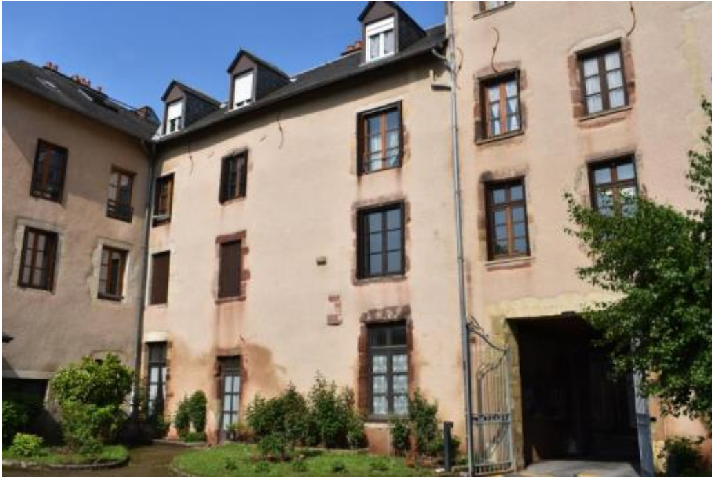
Figure 11 : élévation sur la cour du bâtiment donnant sur la rue de l'Embergue, vue depuis l'est.
