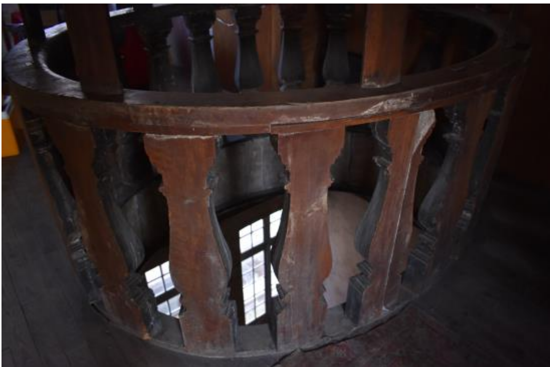
Figure 40 : revers du garde-corps, vu depuis les combles au-dessus du grand escalier.
