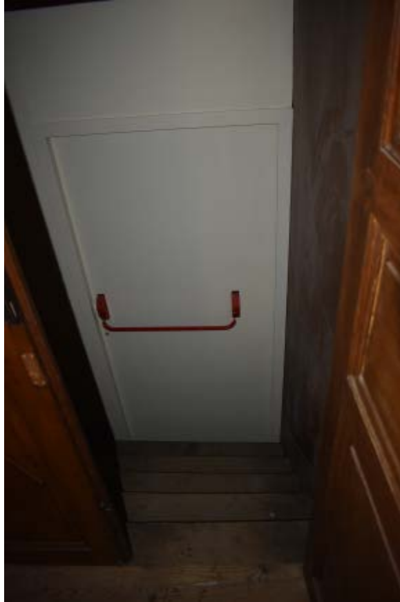
Figure 23 : escalier de communication entre l'actuel deuxième étage et le grand palier de l'escalier.
