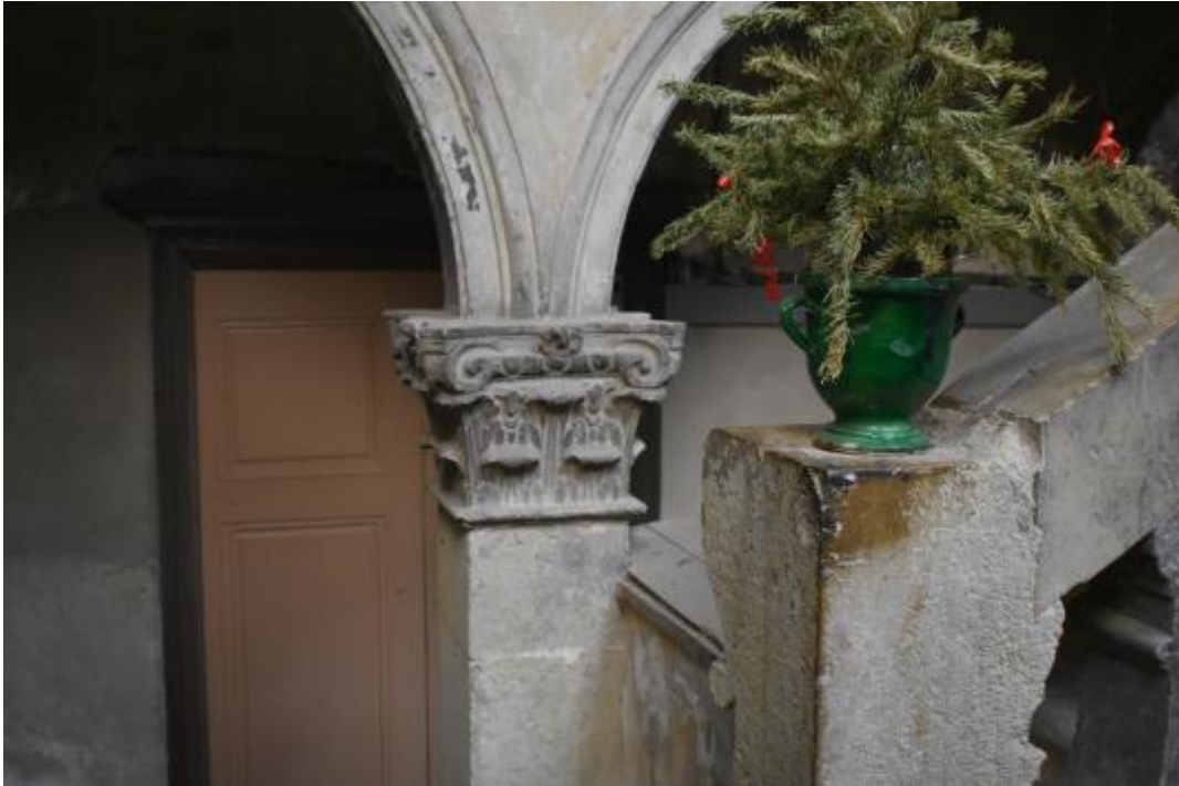
Figure 35 : pilier et chapiteau de l'escalier, vus depuis l'ouest.
