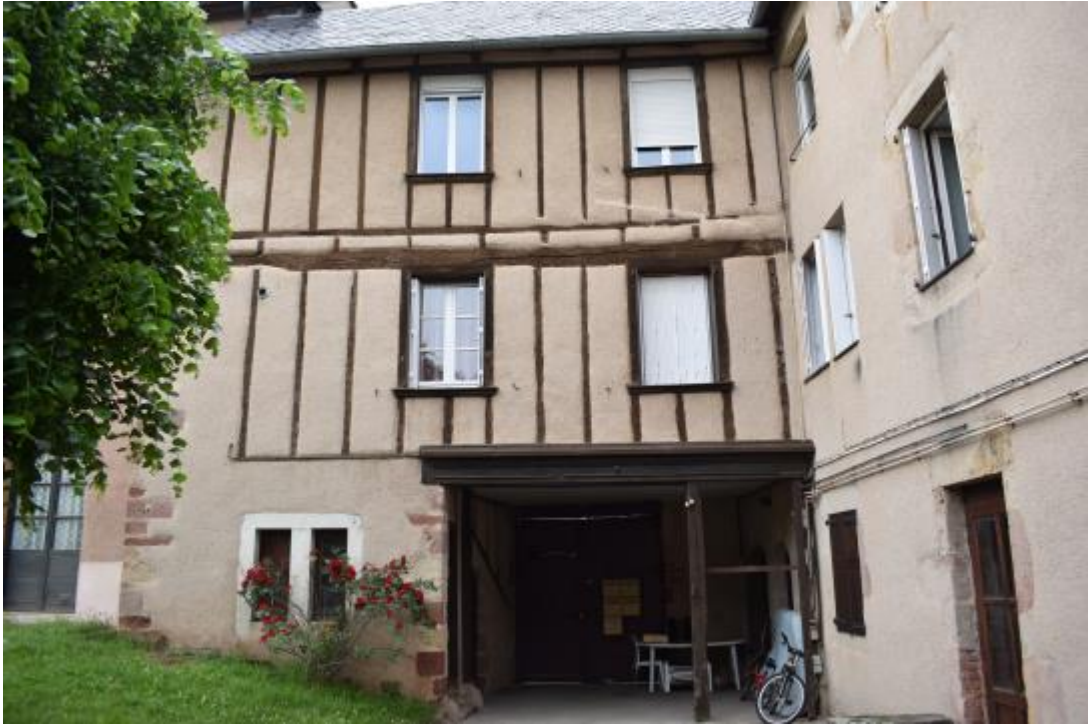
Figure 25 : élévation est de la partie G, façade à pan de bois.
