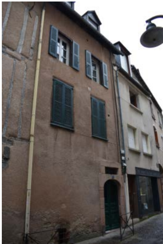
Figure 10 : partie A, vue depuis la rue.
