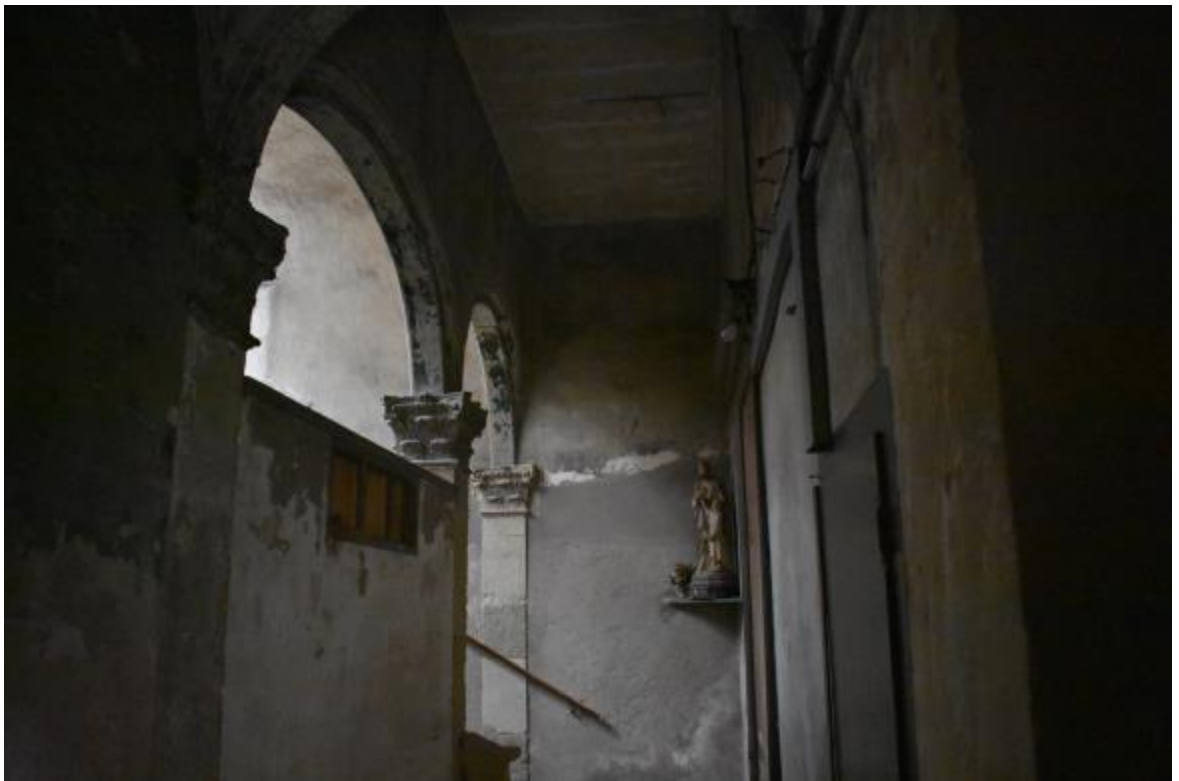
Figure 34 : vestibule du grand escalier, vue depuis le sud.
