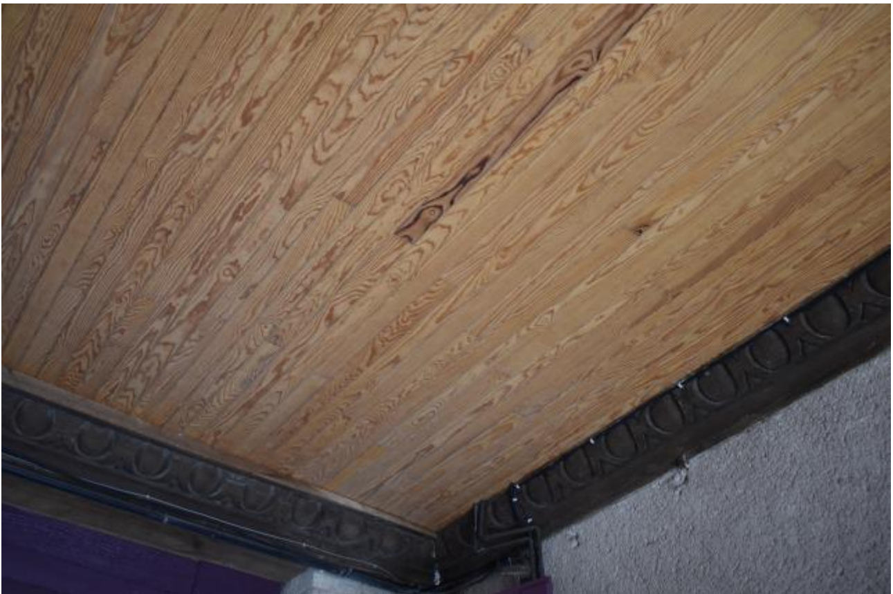
Figure 18 : rez-de-chaussée de la partie D, plafond du porche principal bordé d'une corniche en bois, en forme d'ove et rais de cœur.
