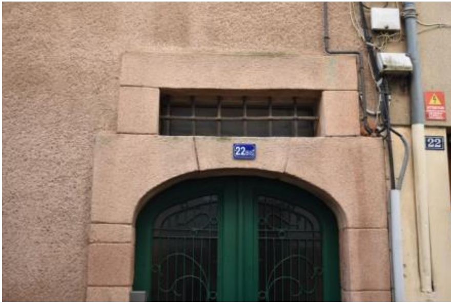
Figure 9 : porte du 22bis, vue depuis la rue.
