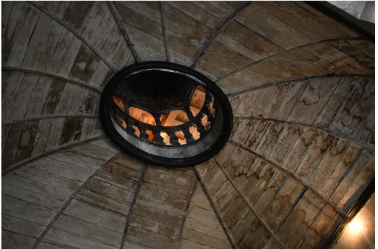
Figure 39 : plafond du grand escalier, fausse voûte lambrissée et lanternon de bois.
