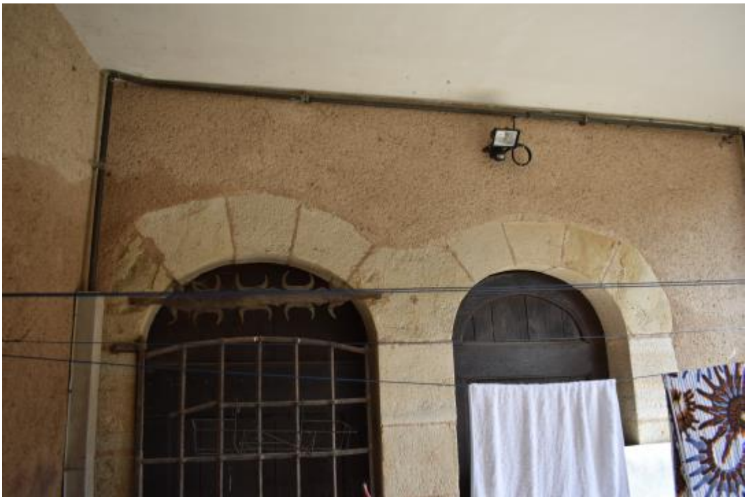
Figure 26 : élévation sud de la partie H, double porte sous le deuxième porche.
