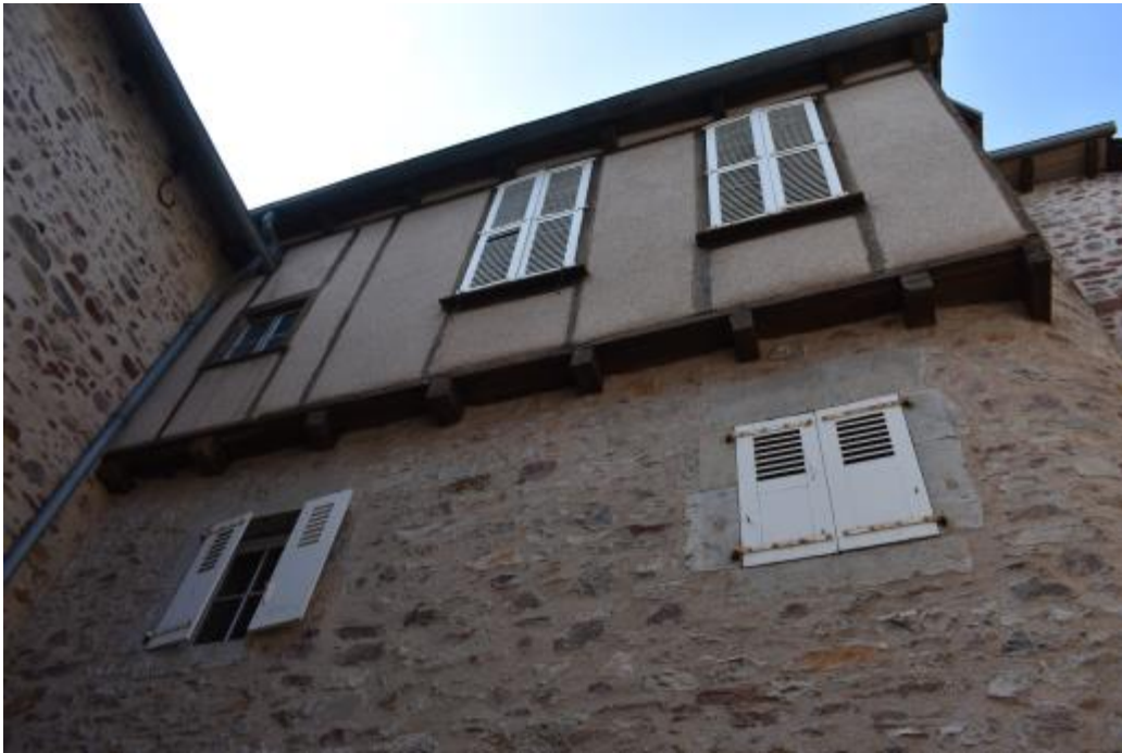
Figure 31 : élévation nord de la partie G, façade en pan de bois à léger encorbellement.
