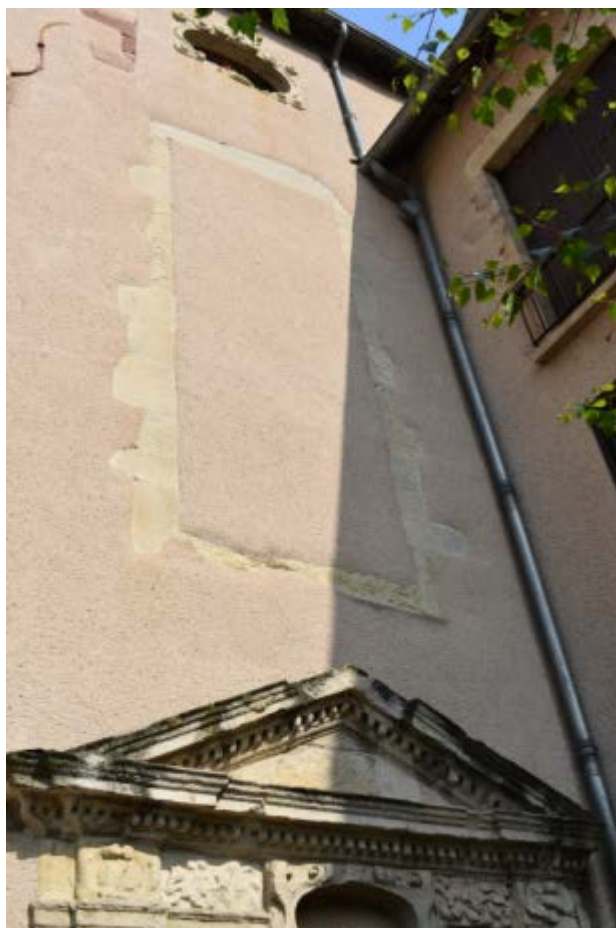
Figure 13 : élévation est de la partie E, grande fenêtre bouchée.
