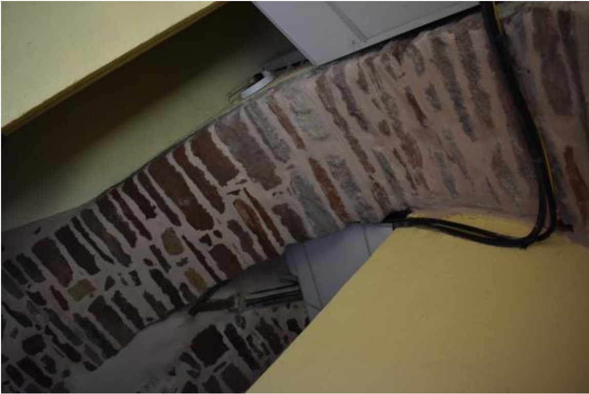
Figure 17 : rez-de-chaussée de la partie A, arc maçonné.
