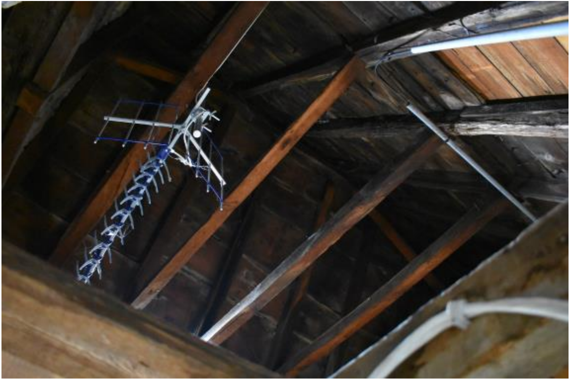
Figure 33 : vue de la charpente de la partie F depuis les combles.
