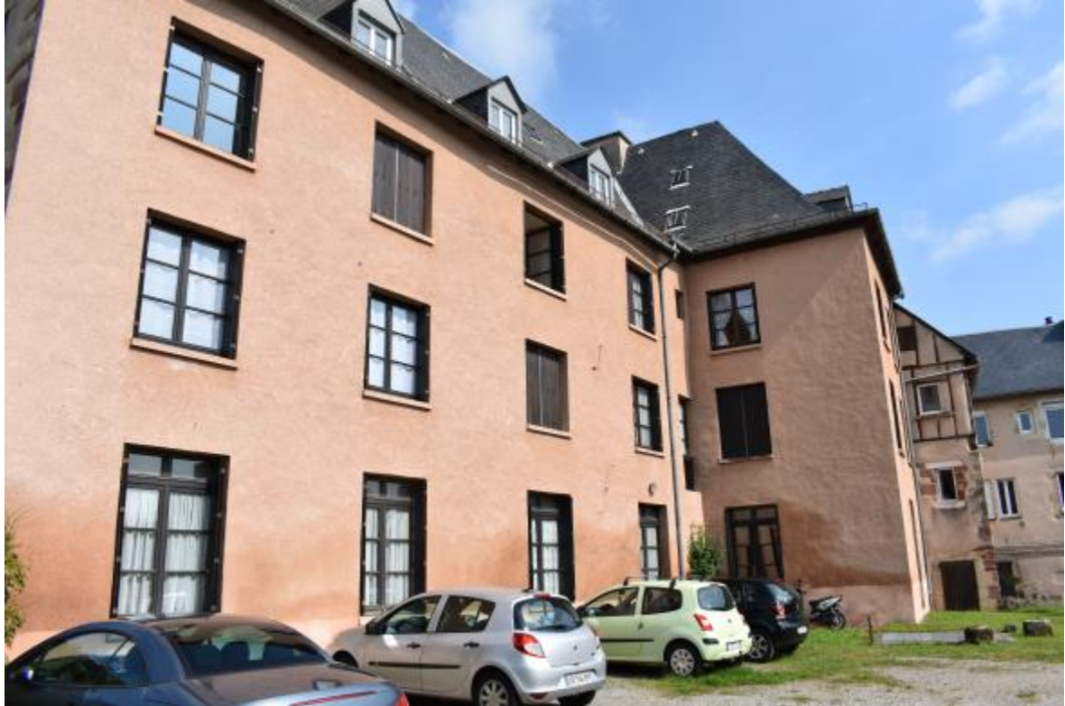
Figure 20 : partie F, élévation du logis principal donnant sur le parking, vue depuis l'est.
