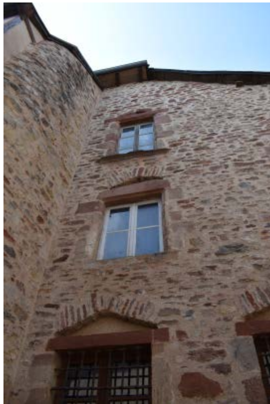
Figure 30 : vue depuis l'ancienne ruelle dite de « la Pinhe », élévation nord de la partie G.
