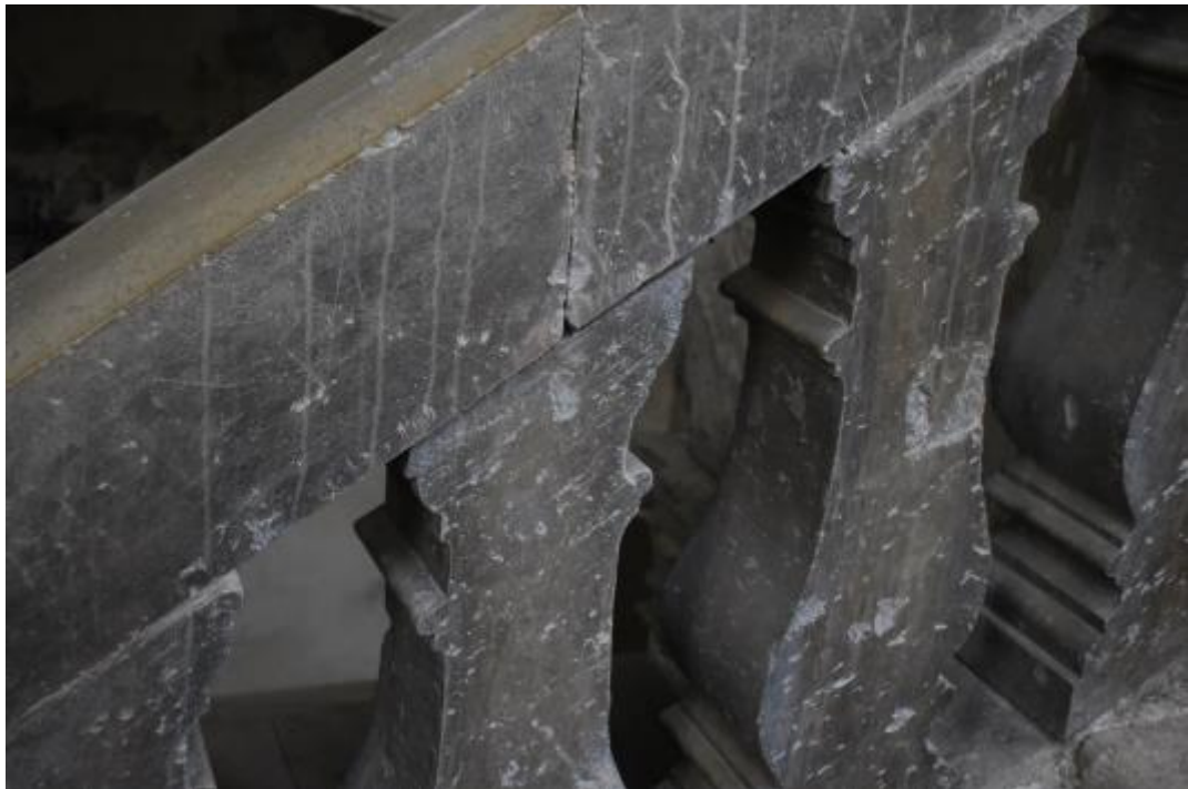
Figure 36 : grand escalier, revers de la rampe avec balustres rampants.
