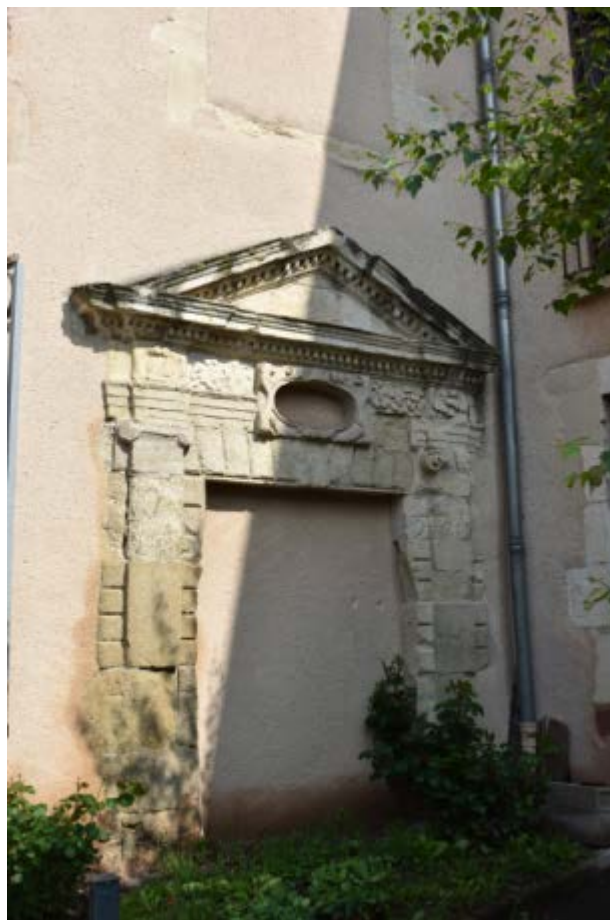
Figure 12 : élévation est de la partie E, porte monumentale.
