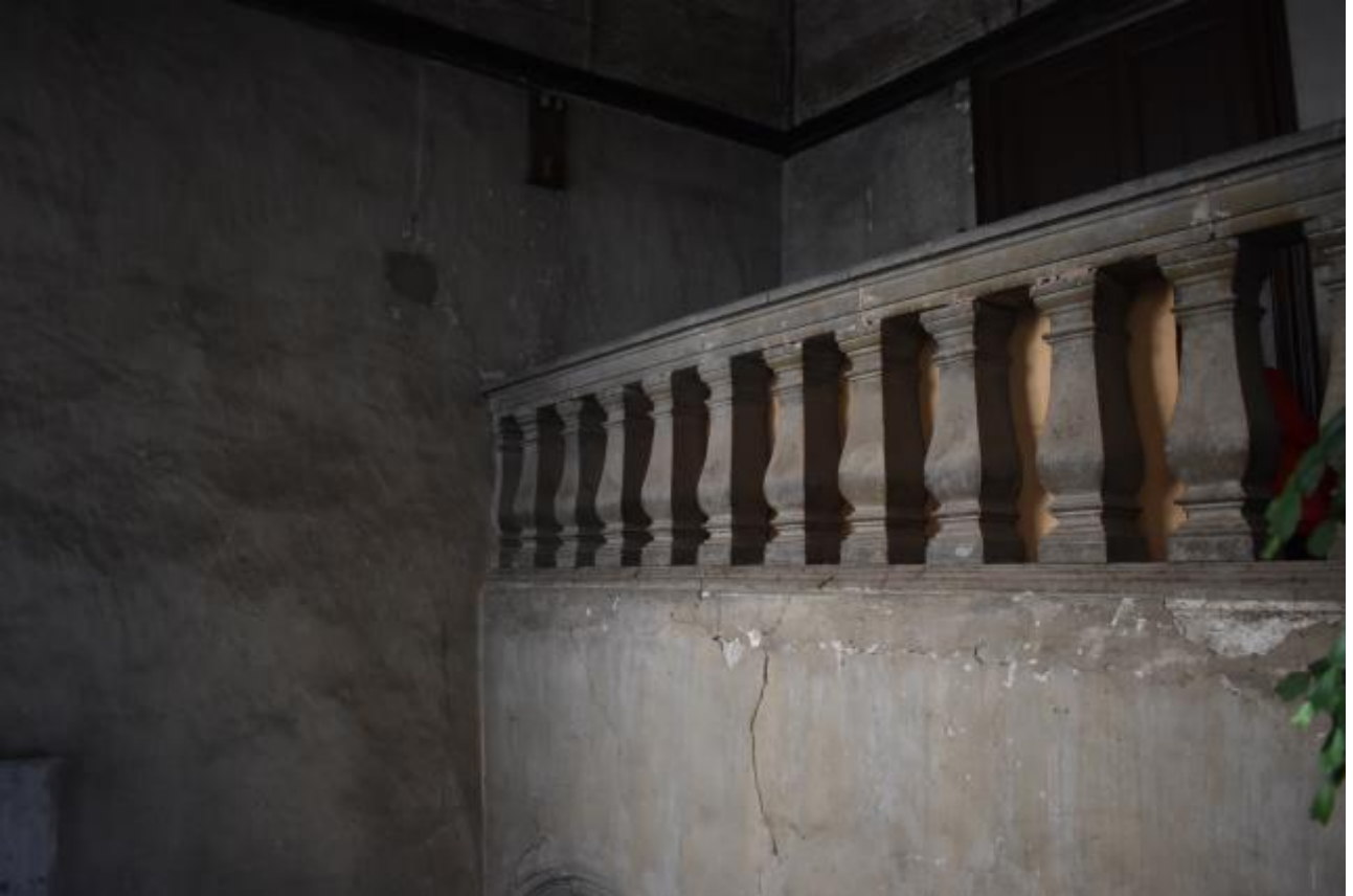
Figure 38 : garde-corps du palier du grand escalier, premier étage, vu depuis l'ouest.
