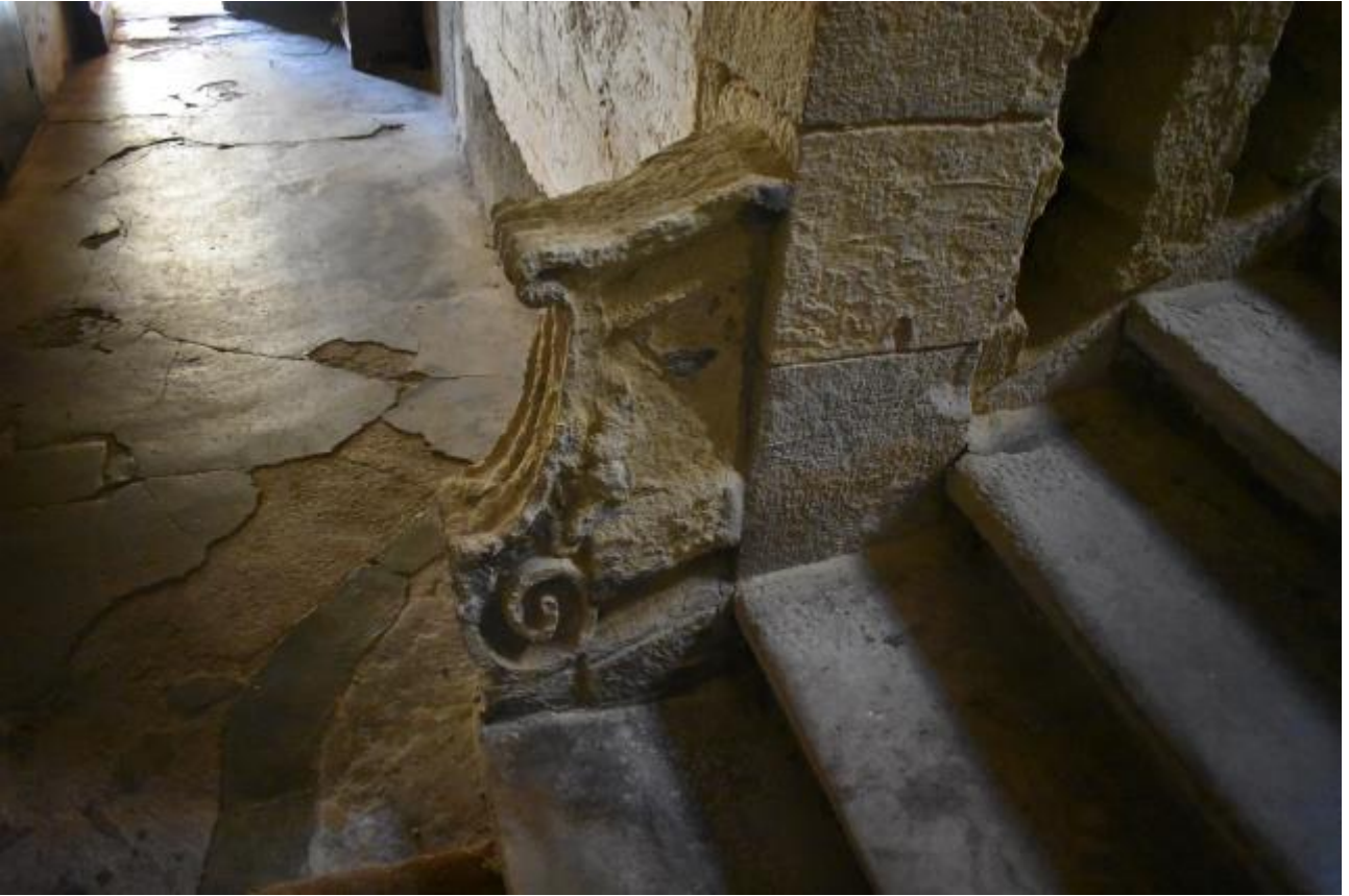
Figure 37 : grand escalier, aileron mouluré du rez-de-chaussée, vu depuis le nord.
