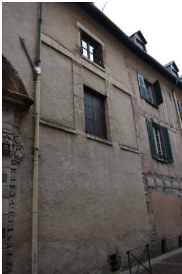
Figure 7 : vue de la partie C depuis la rue
