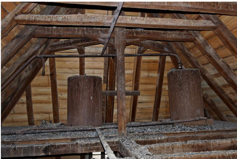
La charpente du pavillon sud-est, niveau du poinçon au-dessus des entrails retroussé.
