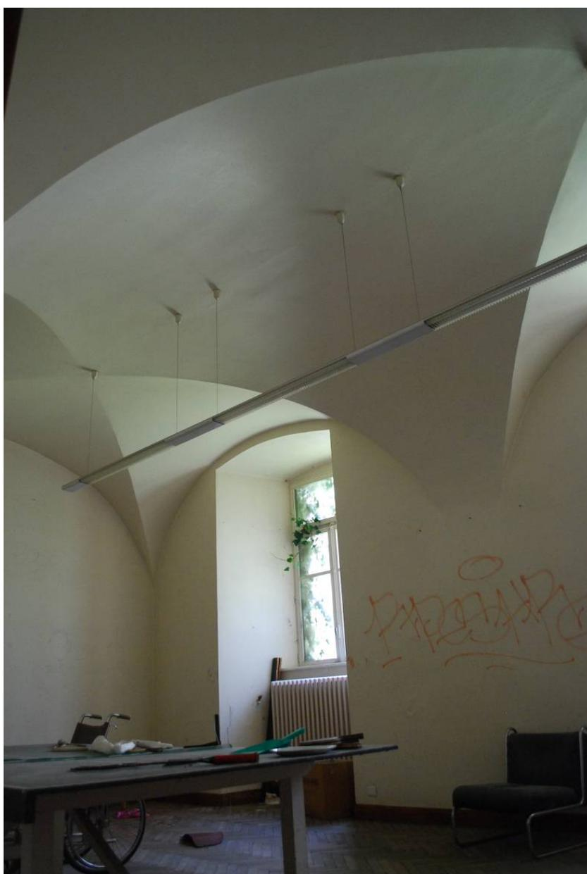
Le rez-de-chaussée voûté d'arêtes du pavillon nord-est.
