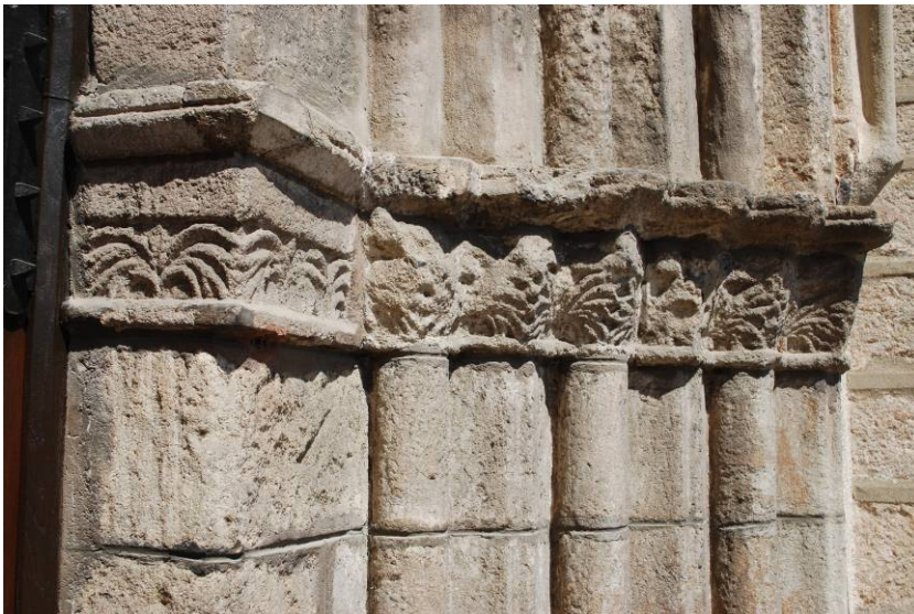
Figure 10 : Le portail sud, détail des chapiteaux-frise du piédroit est.
