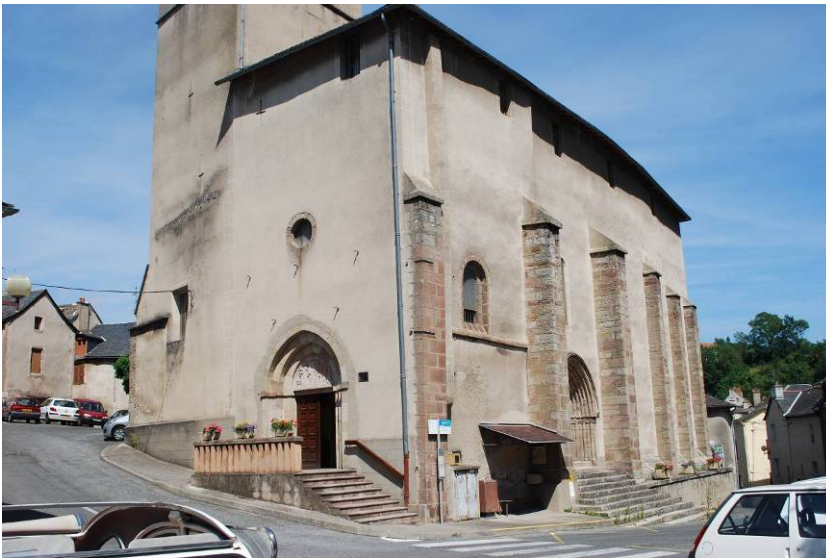
Figure 7 : Vue générale de l'église depuis le sud-ouest.
