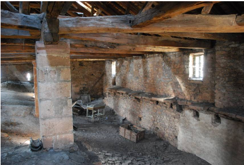
Figure 27 : Le chemin de ronde du mur nord ; dans le parapet crénelé, les merlons ont été bouchés ou transformés en fenêtres.
