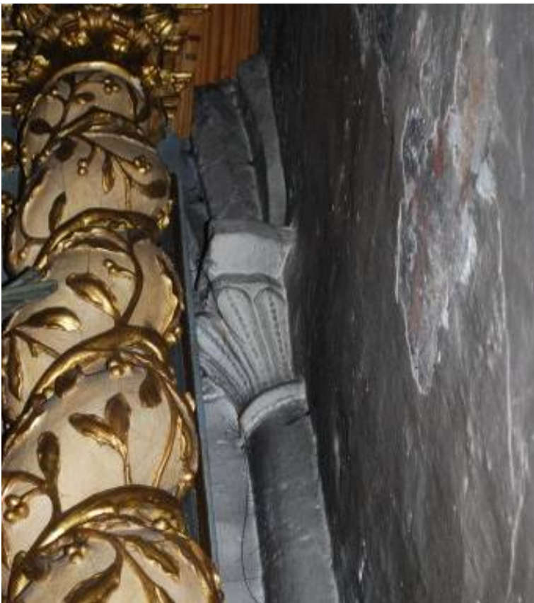
Figure 18 : La colonnette sud-est de la travée de chœur de la nef sud. A droite du chapiteau, sur le mur sud, vestiges d'enduits peints visibles dans les lacunes des badigeons de chaux.
