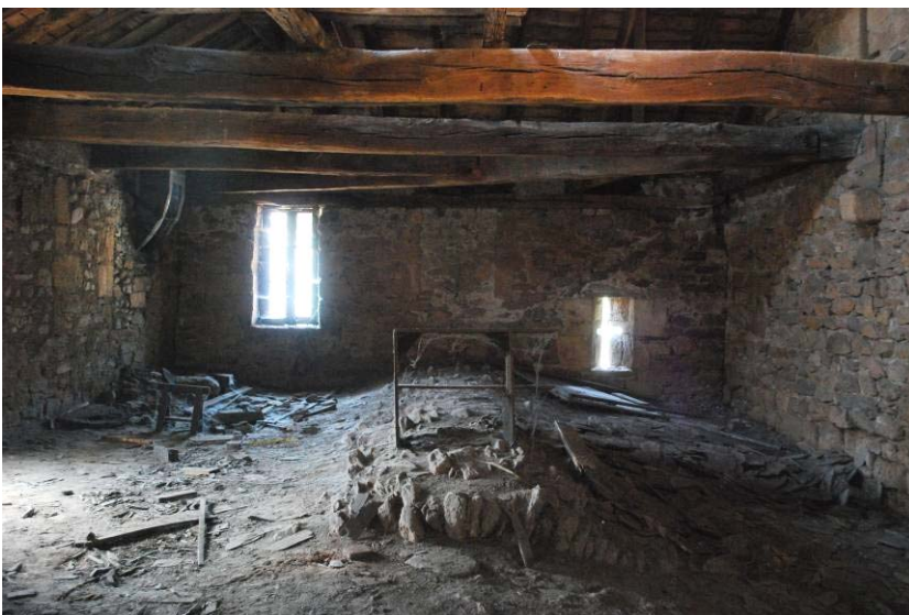
Figure 25 : Elévation ouest au niveau des combles ; à droite la tour clocher ; contre la tour, pente du toit en appentis au-dessus de l'archère, puis parapet crénelé postérieur appuyé dessus. Au premier plan, extrados du berceau de la première travée ouest de la nef sud.
