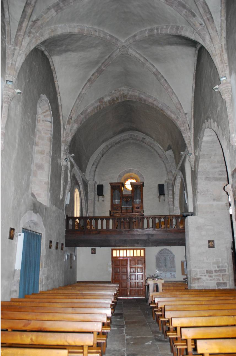
Figure 15 : La nef sud, vue depuis l'Est.
