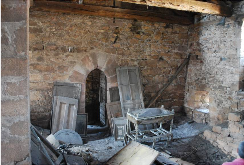
Figure 26 : La tour-clocher au niveau des combles ; la porte.
