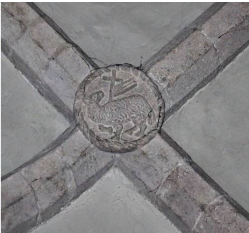
Figure 16 : La clé-de-voûte de la deuxième travée ouest de la nef sud, Agneau pascal.
