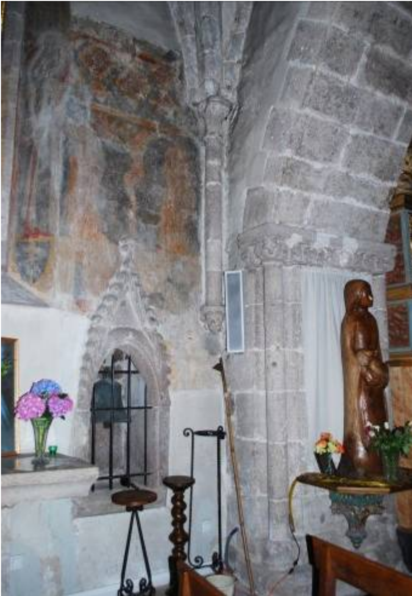
Figure 21 : Le mur est de la nef nord ; supports du XIVe siècle, lavabo liturgique et enduit peint du XIVe siècle : Crucifixion à droite de la fenêtre.
