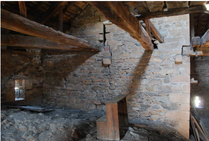
Figure 24 : La tour-clocher au niveau des combles, élévation sud : corbeaux pour porter le toit en appentis couvrant la voûte de la travée sud et l'espace adossé au clocher et pourvu d'une archère à l'ouest ; archère cruciforme au-dessus du niveau de ce toit disparu.
