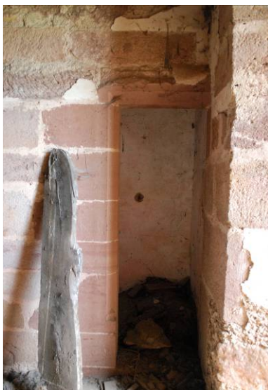
Fig.12. La tour sud-est, second niveau, la porte des latrines.
