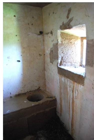
Fig.13. La tour sud-est, second niveau, les latrines.
