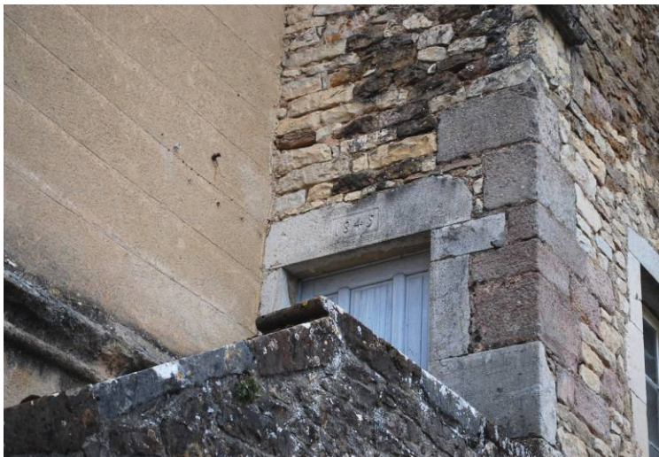
Fig. 6. Porte de l'ancienne école, date portée de 1845 sur le linteau.
