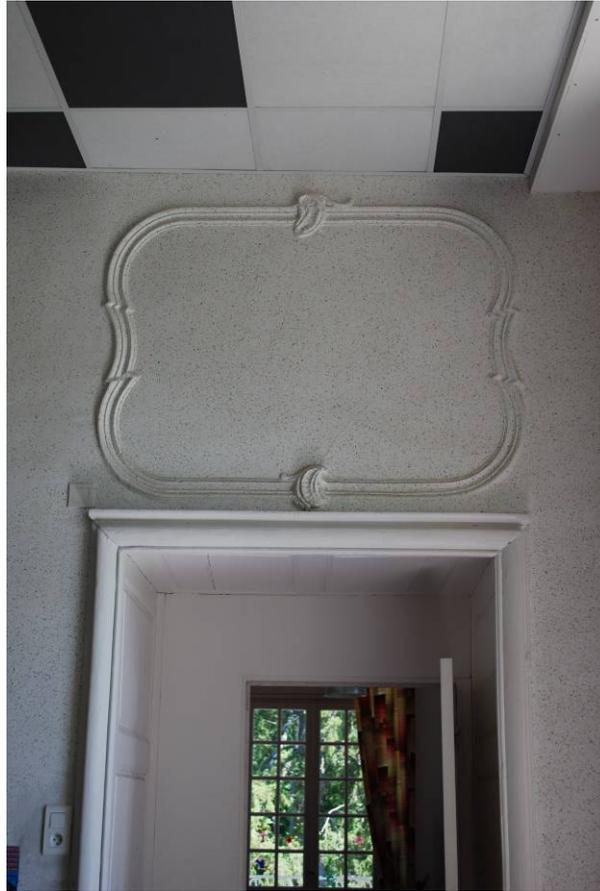
Fig. 52. Salle de l'étage, décor de gypserie du dessus de porte.
