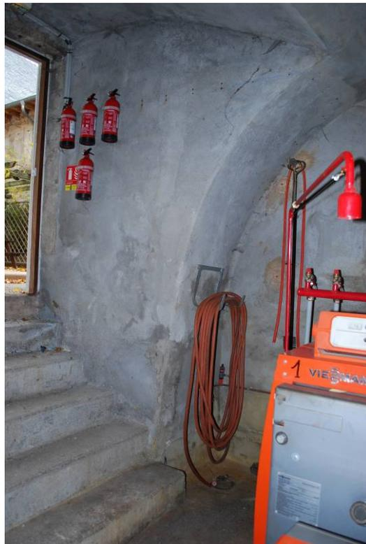
Fig. 33. Cave couverte d'une voûte en berceau plein-cintre, pavillon à l'arrière du logis.
