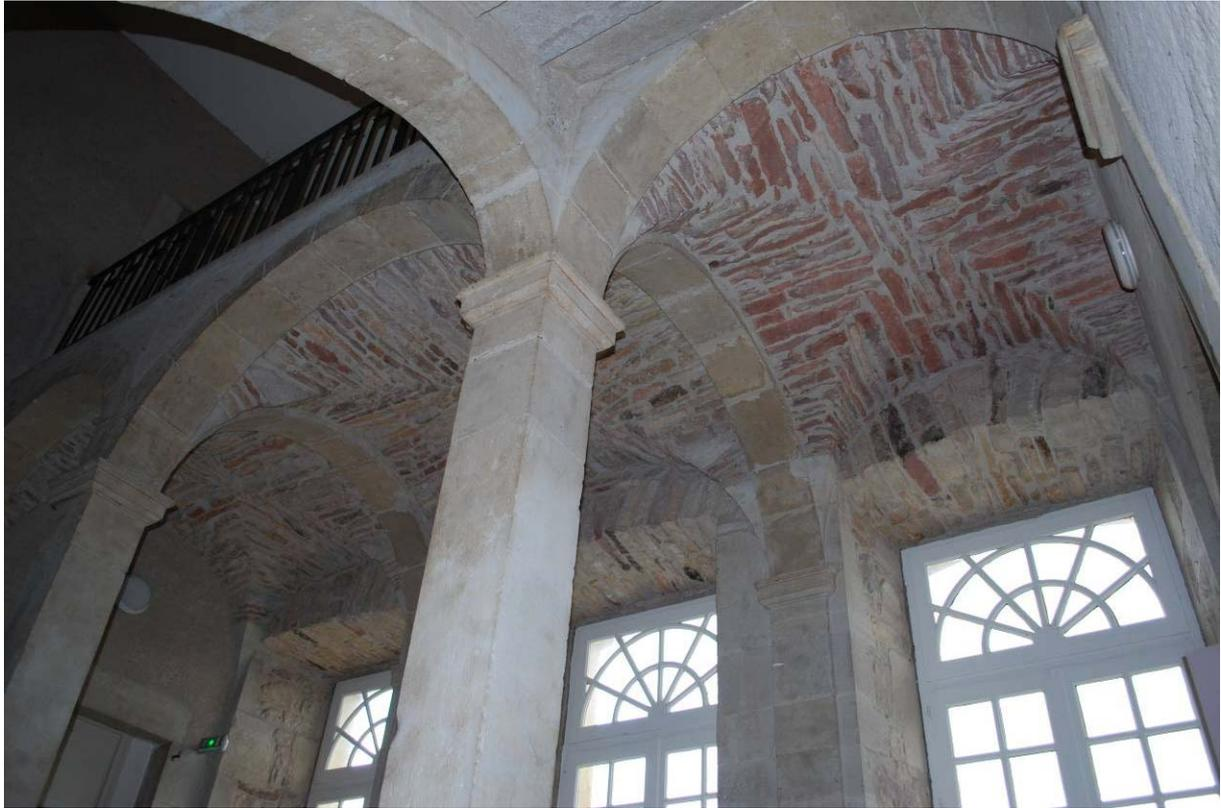
Fig. 36. L'escalier, pavillon central, détail : les voûtes d'arêtes couvrant le premier palier.
