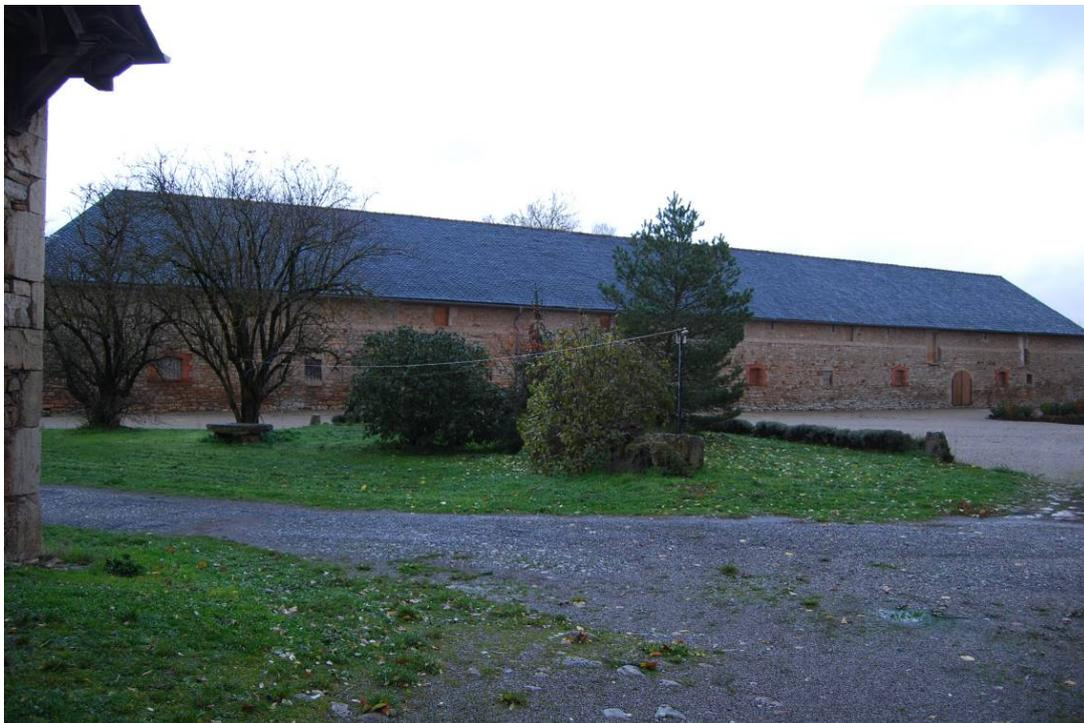
Fig. 11. Dépendance nord : l'ancienne étable. La partie haute résulte d'une surélévation après un incendie.
