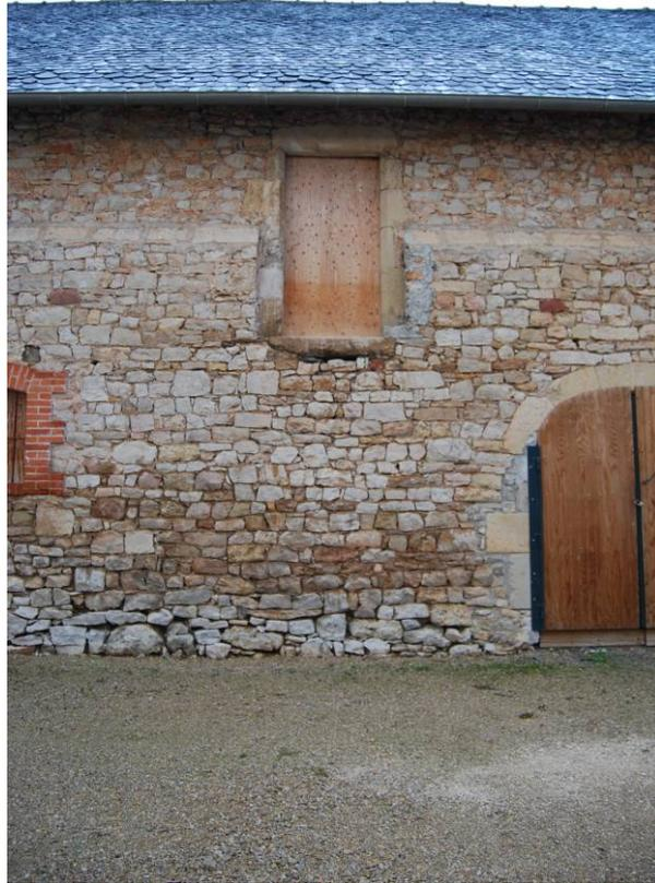
Fig. 12. Dépendance nord : l'ancienne étable. La partie haute et les ouvertures en rempli (ici la porte) résultent d'une surélévation après un incendie.
