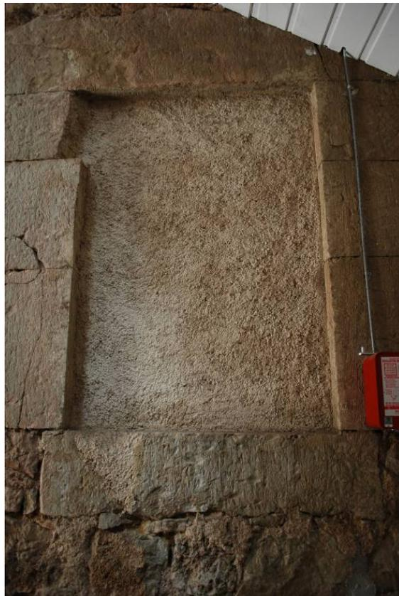
Fig. 47. Fenêtre bouchée dans le mur ouest de l'ancienne cage d'escalier.
