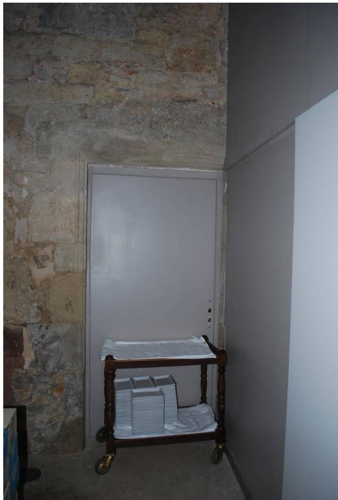
Fig. 56. Les caves sous la galerie, porte bouchée à l'angle sud-ouest.
