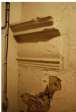
Fig. 60. Le logis, partie occidentale, rez-de-chaussée semi-enterré : couloir vers la chapelle, Détail du manteau de cheminée débordant du mur de refend.
