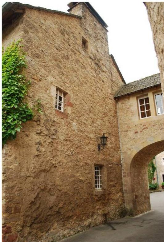
Fig. 20. Pavillon du logis, élévation nord, traces d'arrachement de l'ancien portail.
