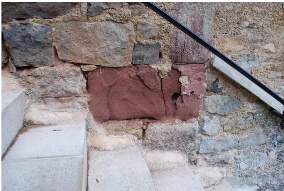
Fig. 25. Maison du métayer, élévation ouest, chaîne d'angle, bloc d'une ancienne bouche à feu en remploi.
