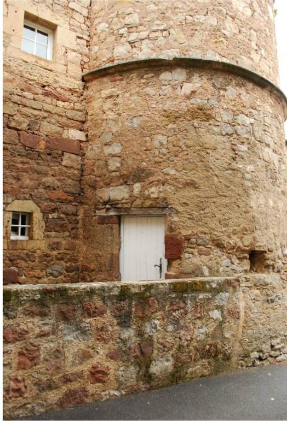
Fig. 19. Rez-de-chaussée de la tour de l'entrée, vue depuis le sud-ouest, traces d'arrachements de l'ancien portail.
