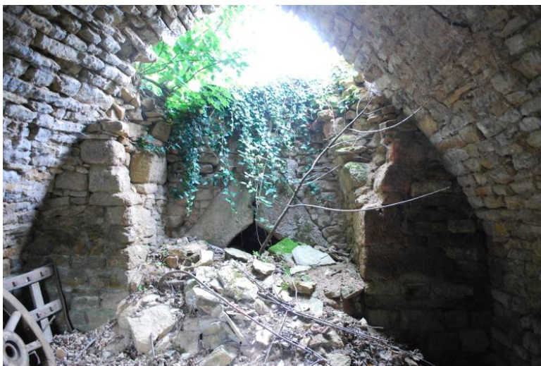
Fig.8. Le fournil et le four au sud du chemin, vus de l'intérieur depuis l'ouest.
