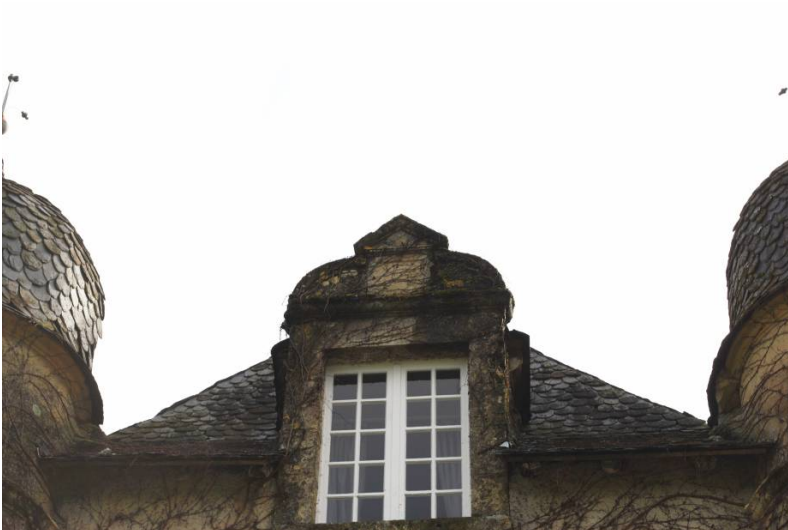
Fig. 23. Mur pignon nord, lucarne à fenêtre pendante et son frontispice.
