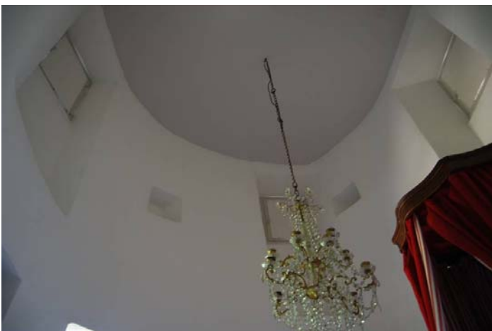
Fig. 39. La tour de l'escalier, partie haute, détail : les niches carrées dans le mur.
