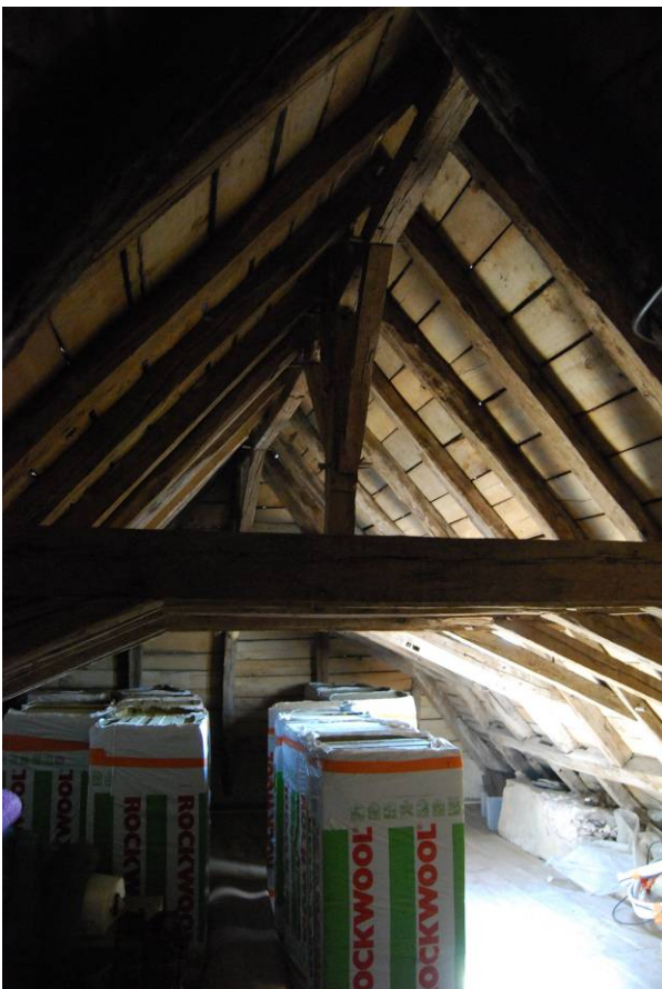
Fig. 41. L'étage de comble, charpente de la partie sud, à entrails et poinçons.
