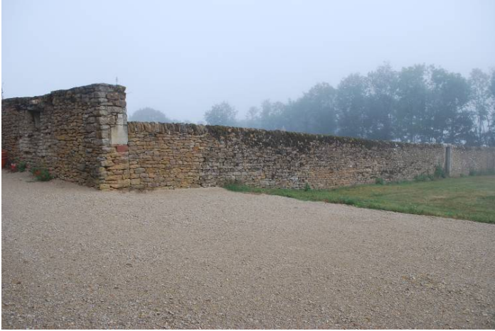
Fig. 9. L'ancien jardin fermé de murs, vu depuis le sud-est.
