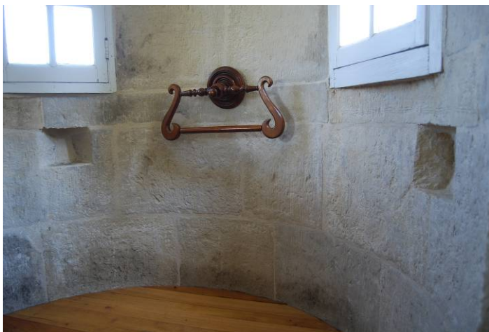
Fig. 36. L'étage en surcroît, chambre nord, échauguette orientale, anciennes canonnières.
