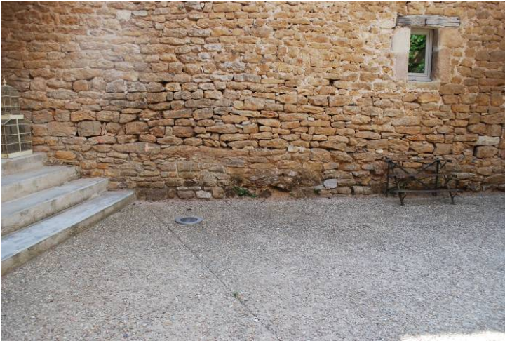
Fig. 13. L'aile de communs ouest, premières assises posées sur le rocher.
