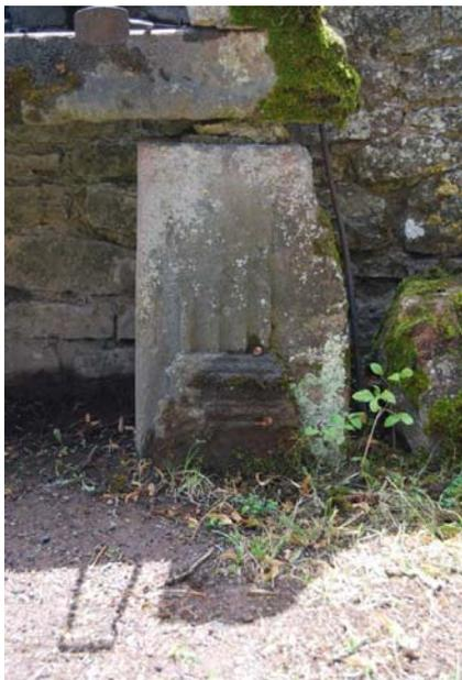
Fig. 19. Élément lapidaire déposé, base d'un pilastre cannelé (élément de droite).
