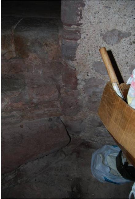
Fig. 30. Partie inférieure de l'escalier, noyau altéré.
