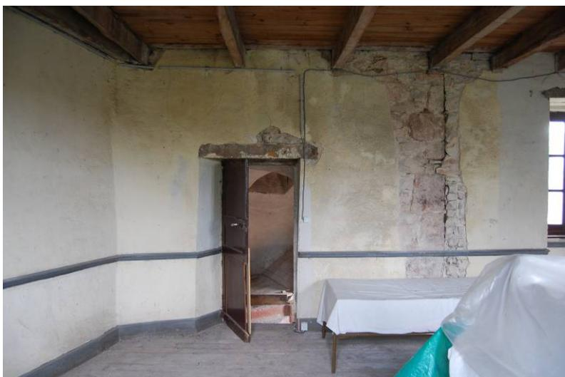
Fig. 38. Second étage, pièce occidentale (chambre), enlèvement de l'enduit témoignant d'une ancienne cloison ou d'un mur de refend.
