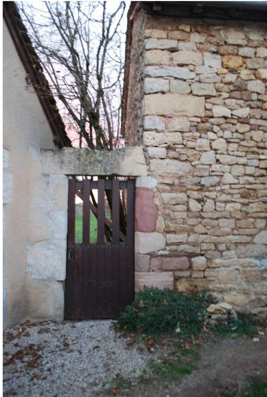
Fig. 19. Piédroit chanfreiné remployé dans l'encadrement de la porte nord entre la cour et les terres à l'ouest.
