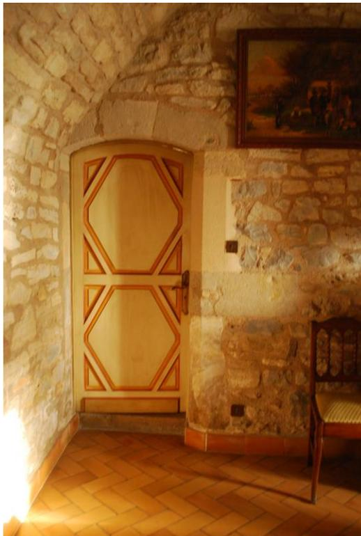
Fig. 23. Rez-de-chaussée, piédroit chanfreiné en remploi dans la porte sud de la cuisine.
