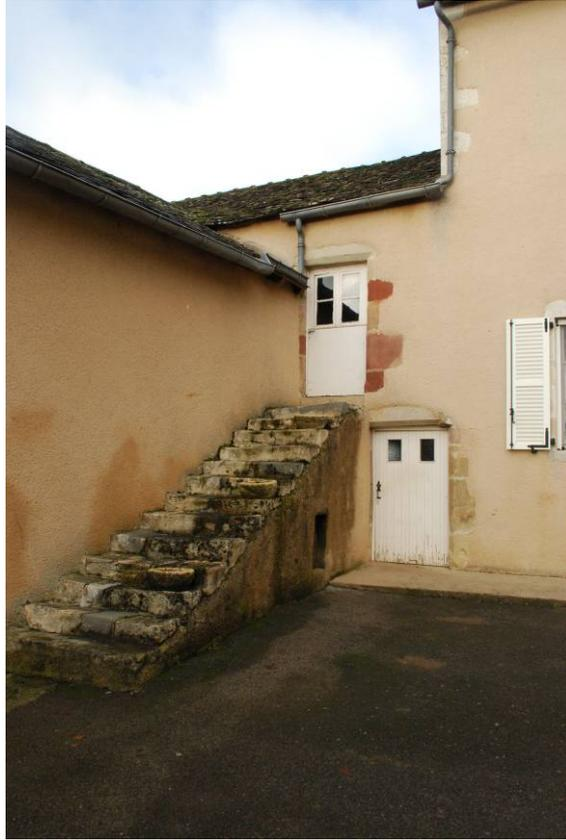
Fig. 14. Extrémité sud du logis, portes aux encadrements chanfreinés en remploi dans une pièce de service.
