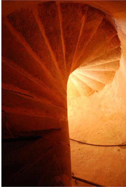
Fig. 22. L'escalier en vis, revers des marches.
