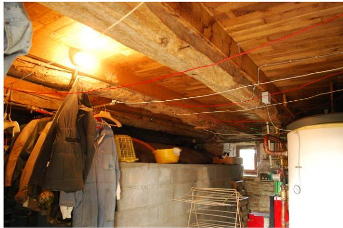
Fig. 38. Poutres en remploi dans la chaufferie, extrémité sud de la demeure actuelle.
