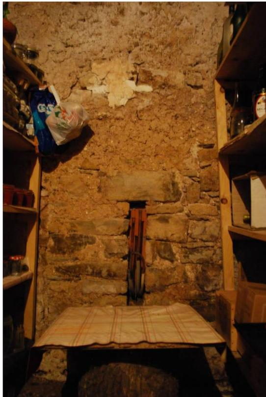
Fig. 30. Mur sud de la cave nord, maçonnerie de bouchage, jour, piédroit à gauche.
