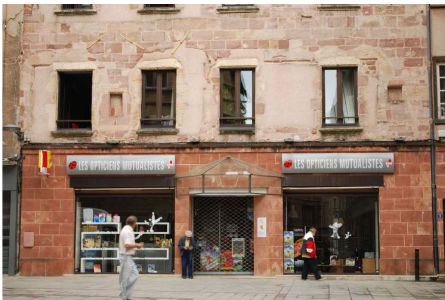
Figure 6 : Façade sur la place de l'Olmet, rez-de-chaussée.
