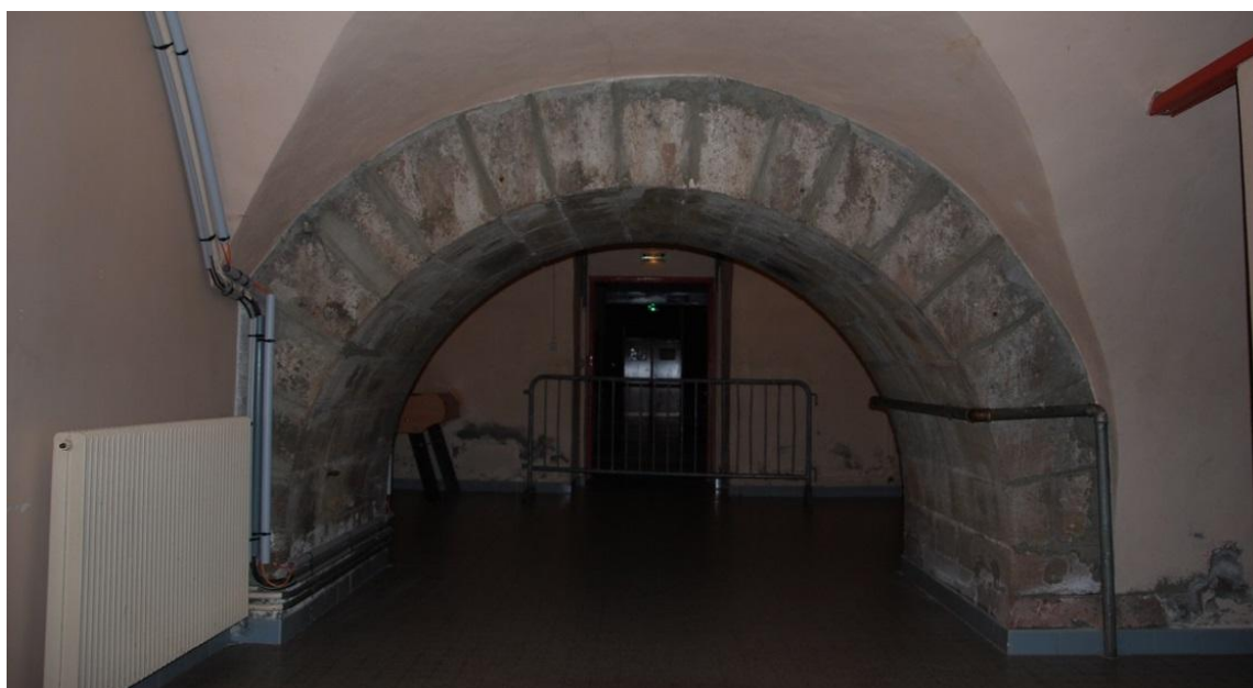
Fig.48 : Vue d'un des vouites des niveaux de soubassement de la partie centrale de l'aile est.
