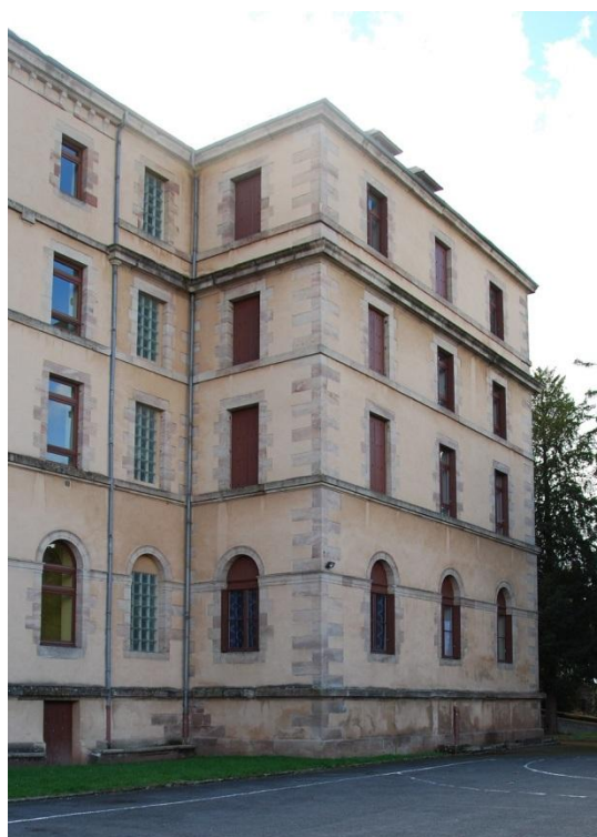
Fig.37 : Vue du pavillon ouest depuis la cour nord.
