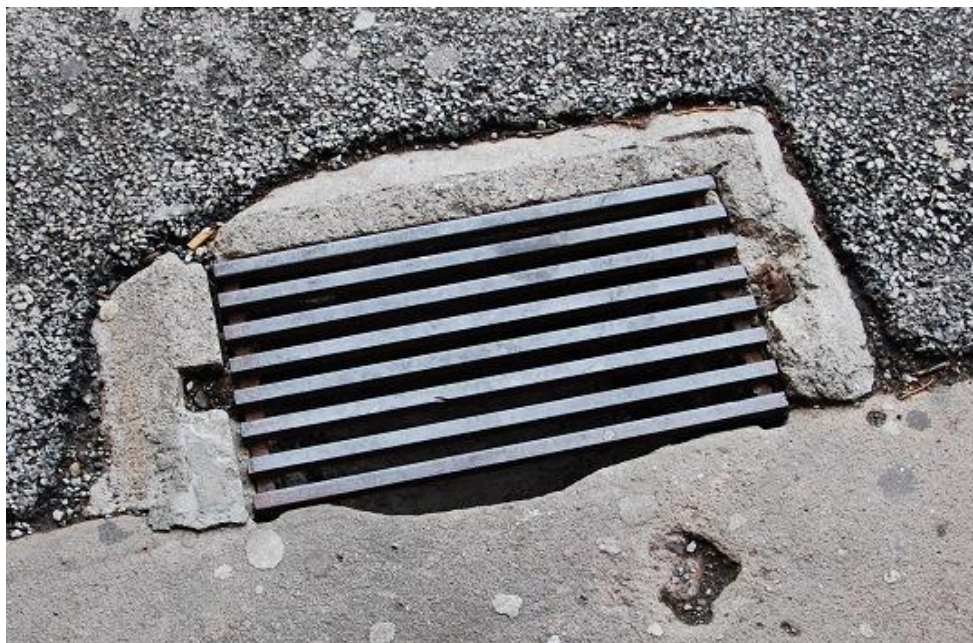
Fig.33 : Bouche de ventilation située dans la cour sud au pied permettant l'aération du niveau de soubassement du corps principal.
