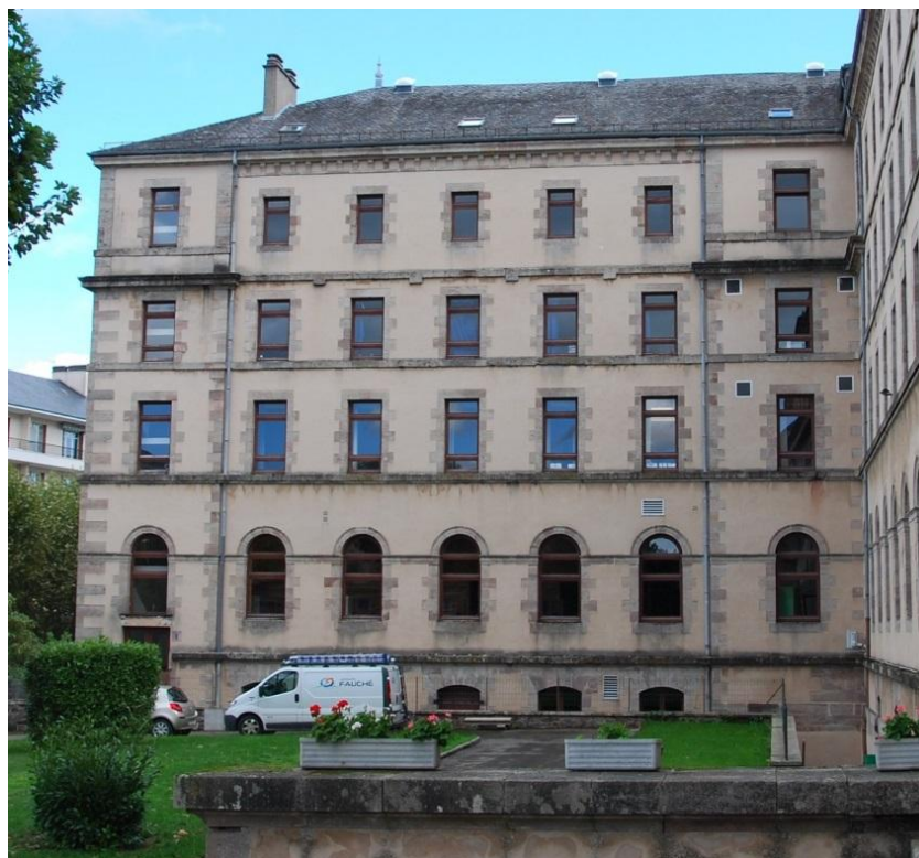
Fig.44 : Vue de la façade ouest de l'aile est donnant sur la cour nord.
