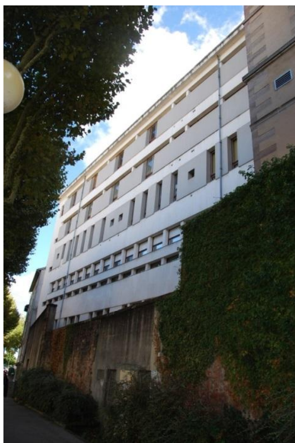
Fig.51 : Vue de la façade nord de l'aile contemporaine située à l'est du site du collège Joseph Fabre.
