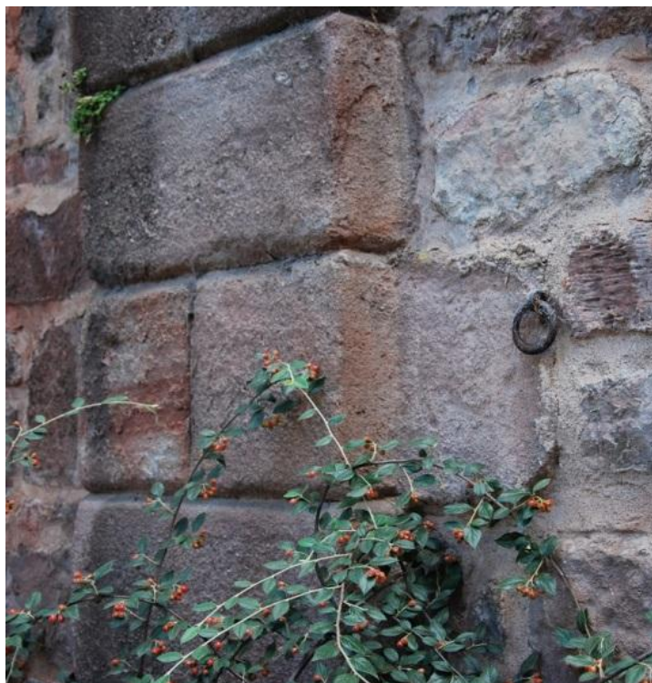
Fig.19 : Vue du mur de soutènement du collège Fabre.
