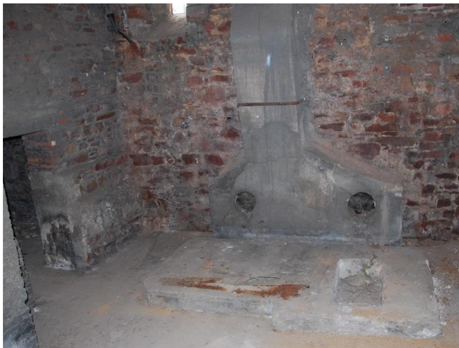
Fig.41 : Vue de la dalle et du conduit de cheminé de l'ancienne chaufferie à charbon du collège.
