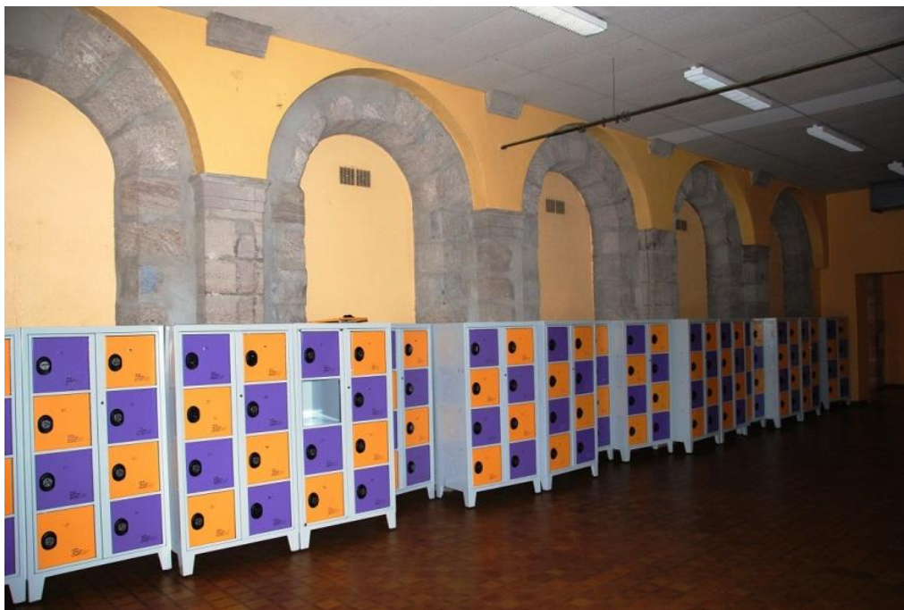
Fig.50 : Vue de la rangée d'arcades format portique située dans la partie centrale du rez-de-chaussée de l'aile est.
