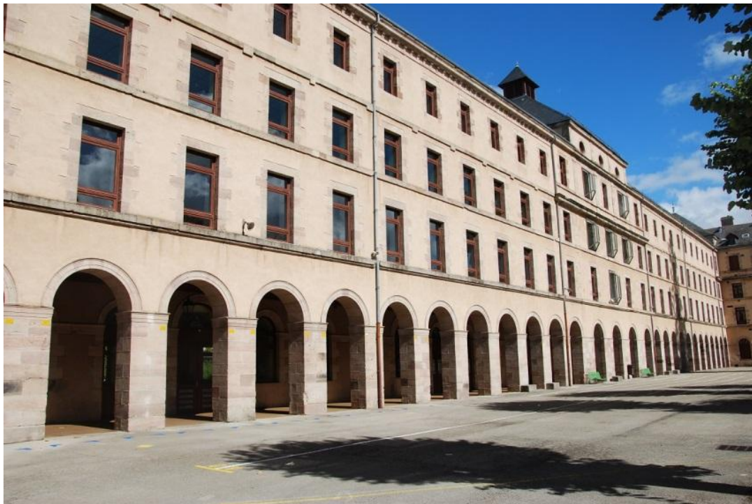
Fig.32 : Vue du corps central du bâtiment depuis la cour sud.
