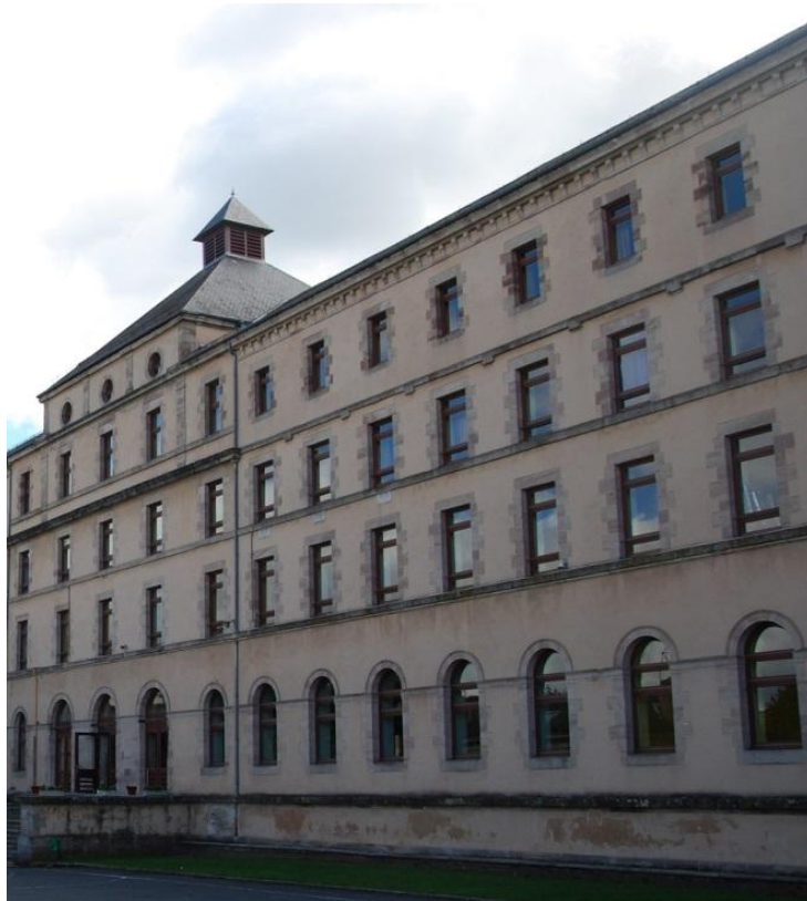
Fig.31 : Vue d'une partie de l'aile droite du corps principal en prolongement du pavillon central depuis la cour nord.
