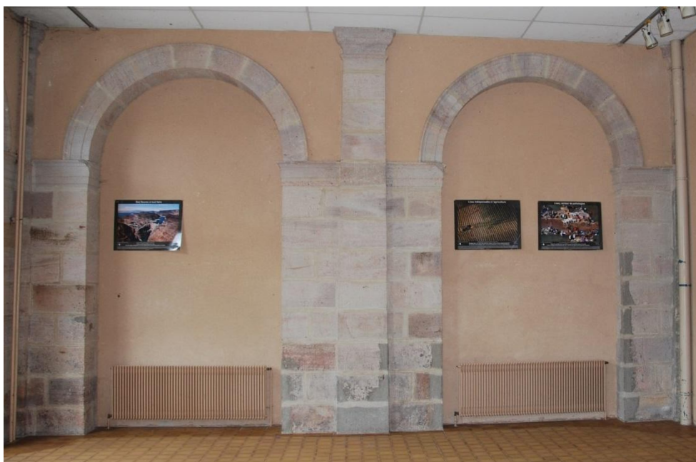
Fig.26 : Vue des arcades situées au niveau de la cloison est du vestibule du pavillon central.
