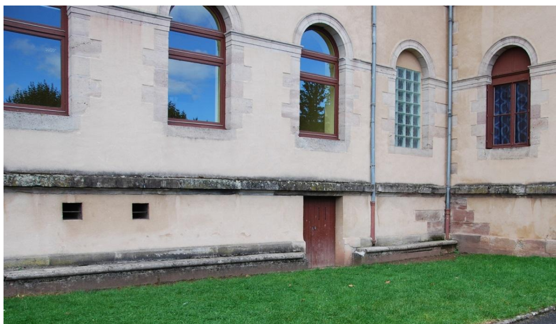
Fig.30 : Vue du niveau de soubassement situé à la base de l'aile droite du corps principal du bâtiment depuis la cour nord.
