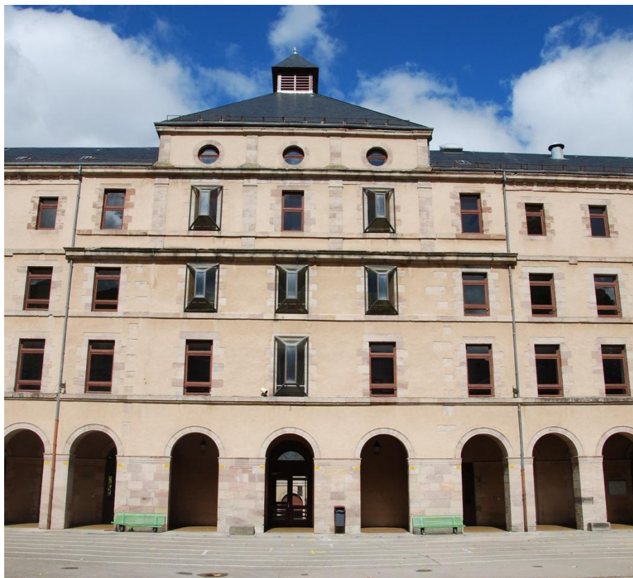
Fig.25 : Vue de la façade sud du pavillon central.
