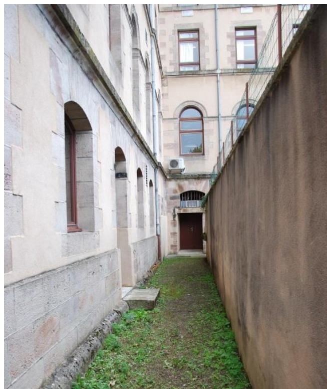
Fig.43 : Vue du corridor extérieur permettant d'accéder aux portes ménagées au niveau des étages de soubassement de l'aile est. Au fond de ce corridor, la porte donnant sur la salle de classe située dans le corps principal.
