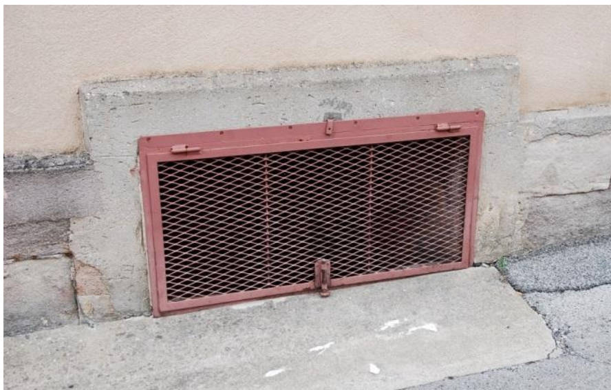
Fig.39 : Vue du soupirail servant au remplissage de la fosse à charbon du collège.
