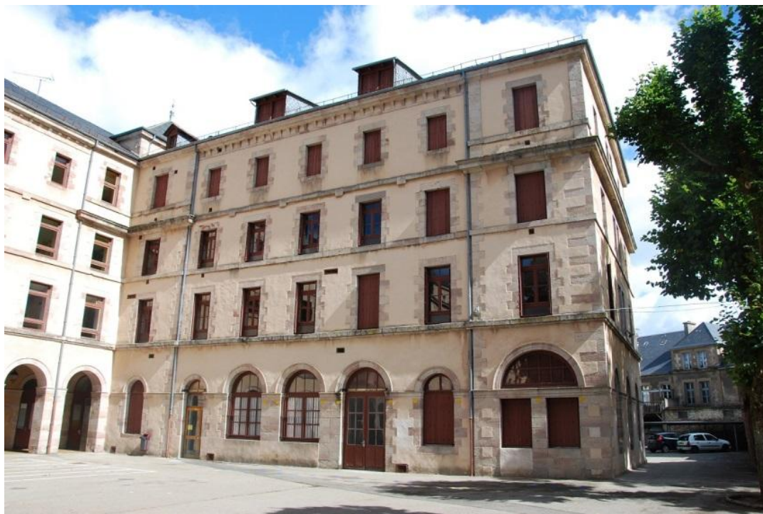
Fig.46 : Vue général de la façade ouest donnant sur la cour sud de l'aile est du bâtiment.
