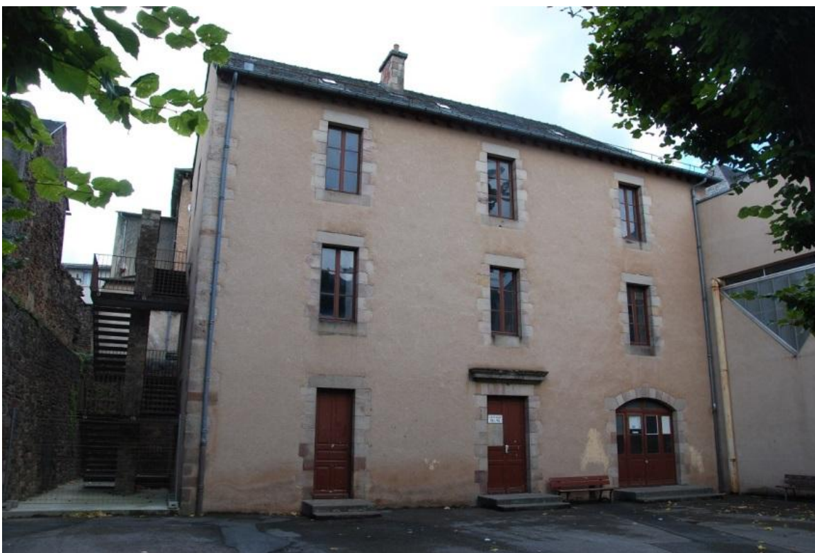
Fig.53 : Vue de la dépendance attenante au gymnase située au niveau de la cour sud.
