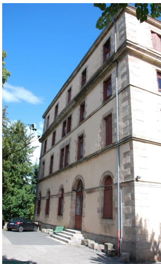
Fig.38 : Vue de la façade ouest du pavillon ouest du bâtiment.
