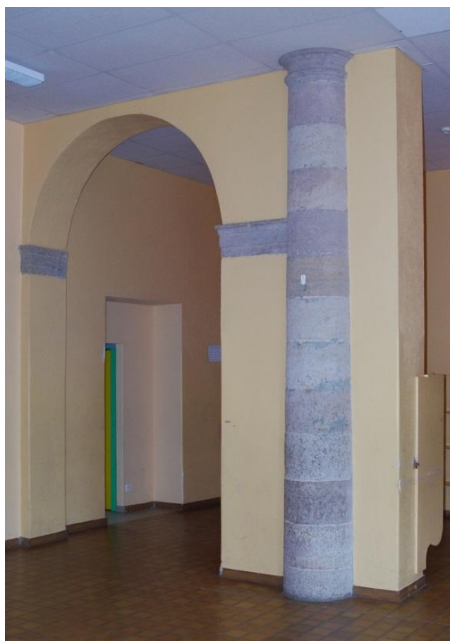
Fig.49 : Vue d'une des colonnes engagées et d'une arcade aux impostes moulurées intégrées dans les travaux de réfection des espaces du collège.
