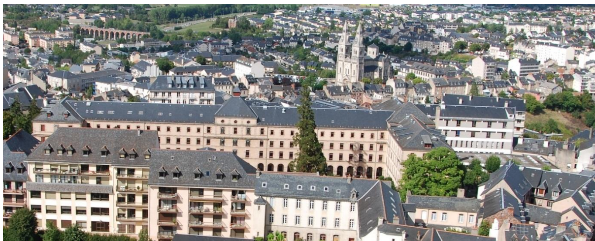
Fig.14 : Vue générale du bâtiment montrant la façade sud du collège.
