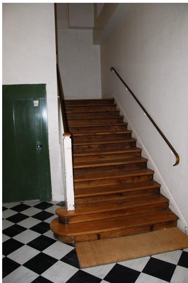
Fig.40 : Vue de l'escalier intérieur en bois du pavillon ouest.
