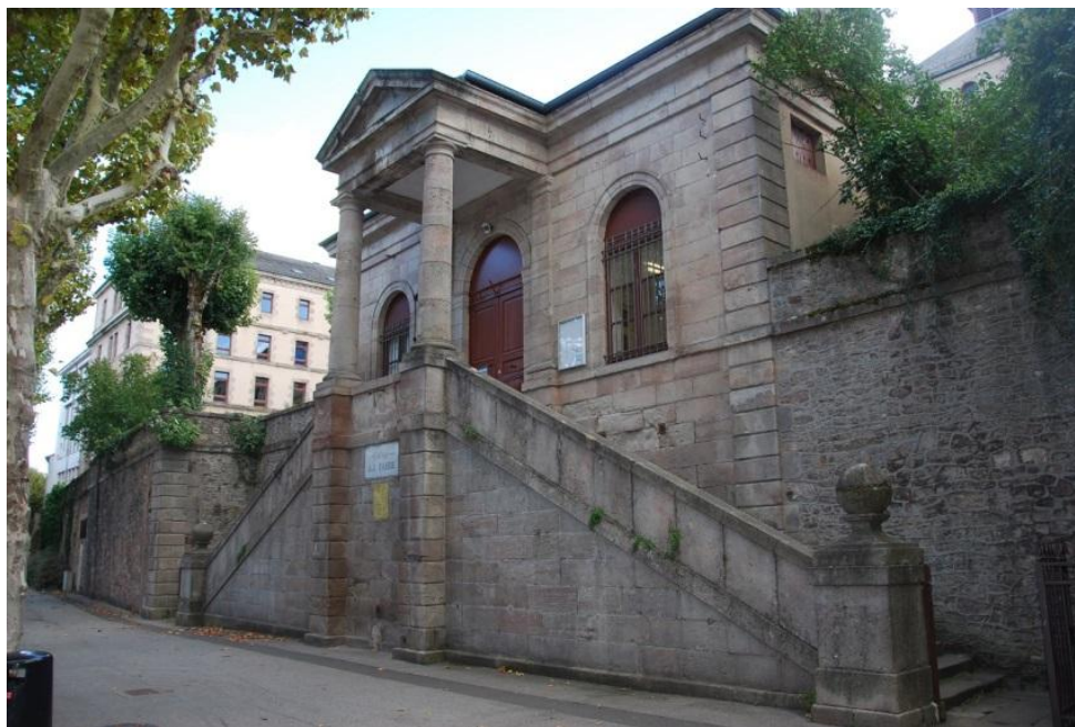
Fig.15 : Vue de l'entrée principale du collège Fabre.
