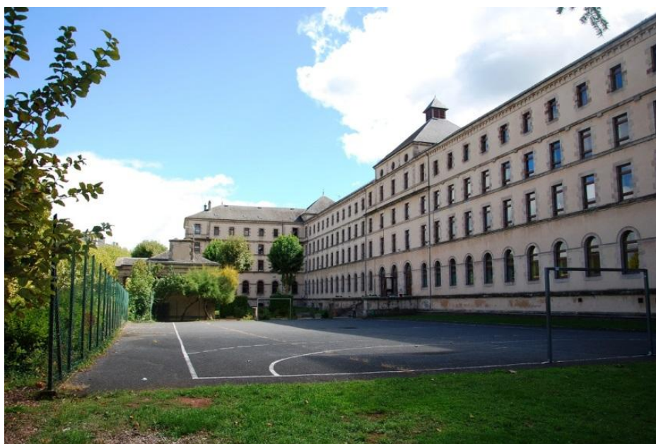
Fig.23 : Vue de la cour nord et du bâtiment principal.
