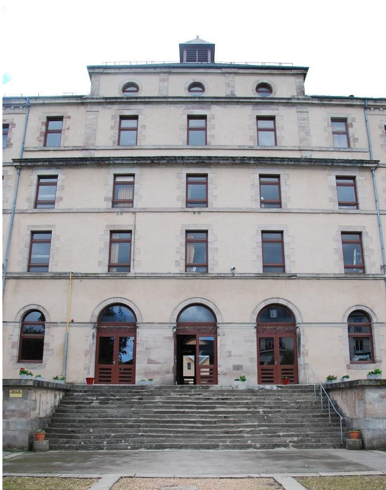
Fig.24 : Vue de la façade nord du pavillon central.
