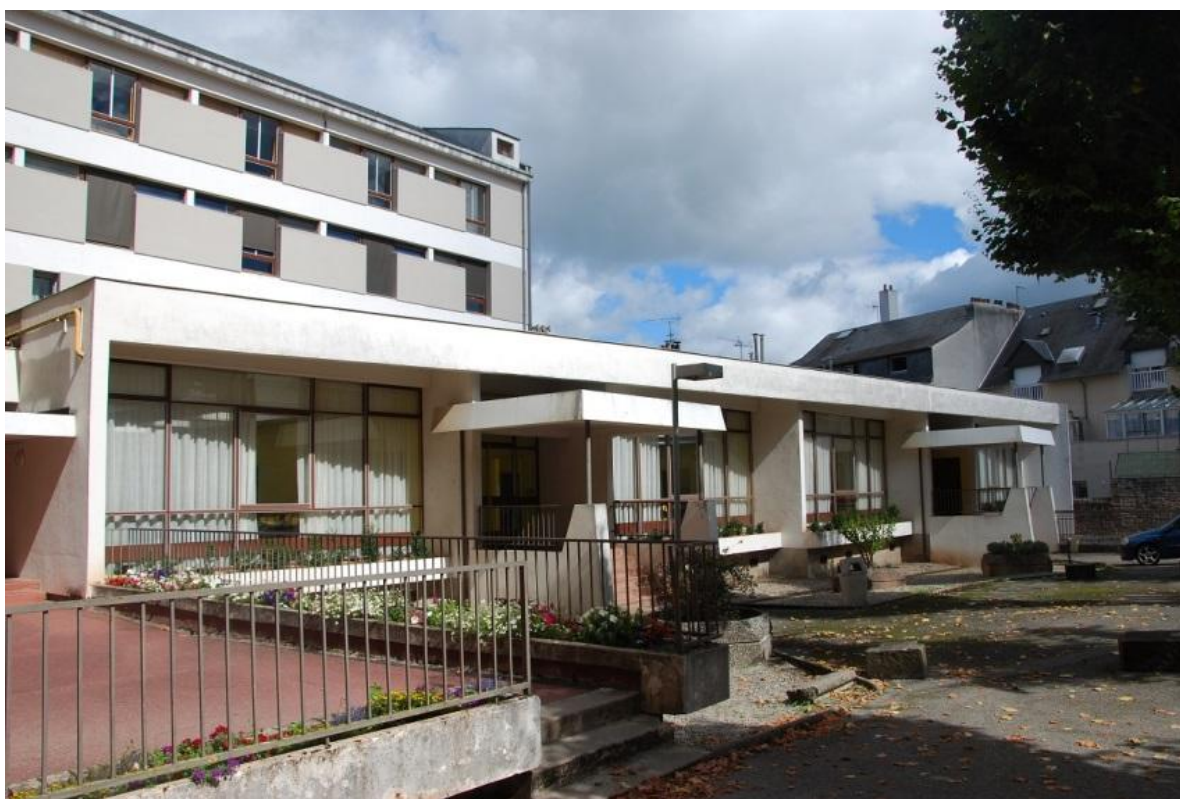
Fig.52 : Vue de l'avant-corps de bâtiment de l'aile contemporaine.
