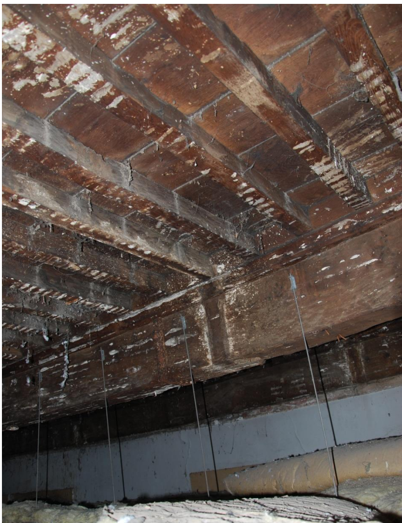
Le plafond du deuxième étage du pavillon sud-est (dissimulé par un faux plafond).
