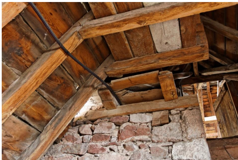
La charpente du pavillon sud-est, extrémités moulurées des blochets en surplomb du mur (ici pris sous la couverture de l'aile nord).
