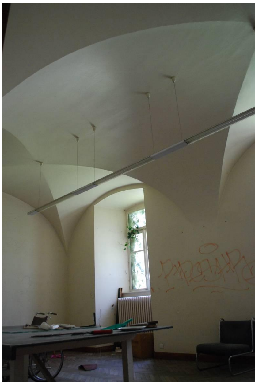
Le rez-de-chaussée voûté d'arêtes du pavillon nord-est.
