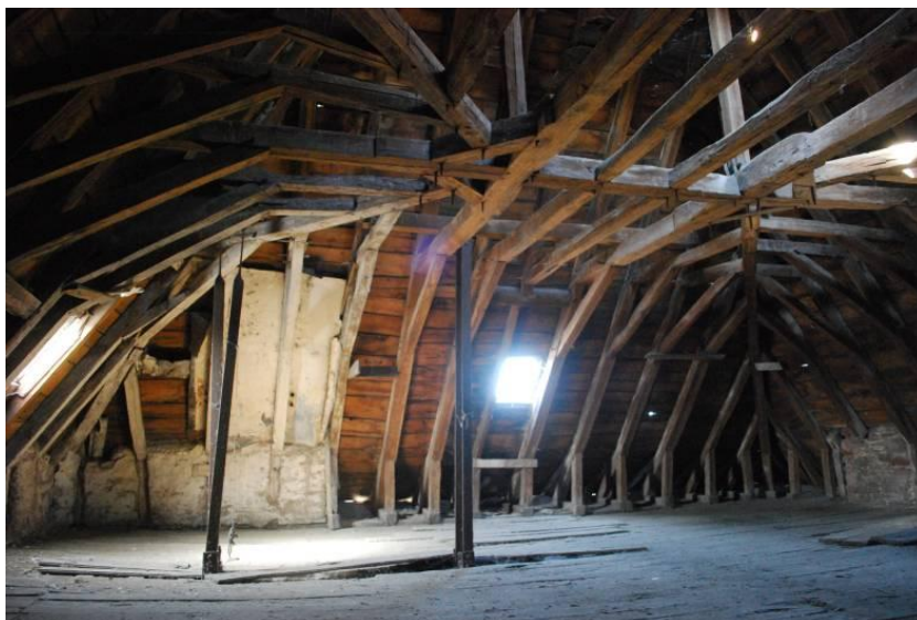
La charpente du pavillon sud-ouest.
