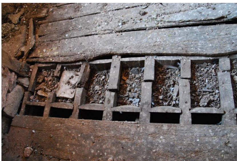
Montage des solives et aies d'entrevous du plafond du deuxième étage du pavillon sud-est (détail visible depuis le niveau de comble).
