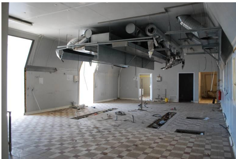
Une pièce du rez-de-chaussée de l'aile sud ; la voûte en berceau est dissimulée par le faux plafond qui suit sa forme.
