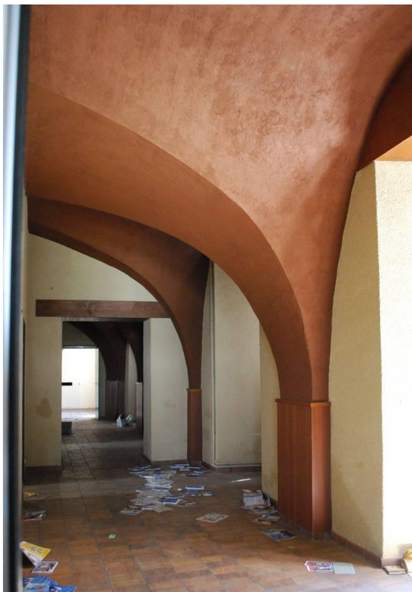
Le rez-de-chaussée voûté de la partie ouest de l'aile nord.
