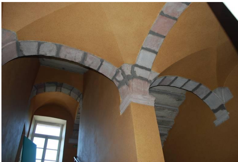
Un des deux escaliers (celui contre le pavillon sud-est) du dernier quart du XVII e siècle ; détail des voûtes d'arêtes d'un palier et des arcs portant els volées droites des marches en pierre.
