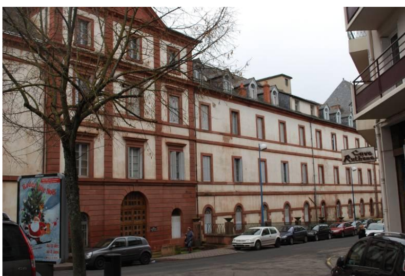
L'élévation ouest de l'aile nord sur la rue Combarel.
