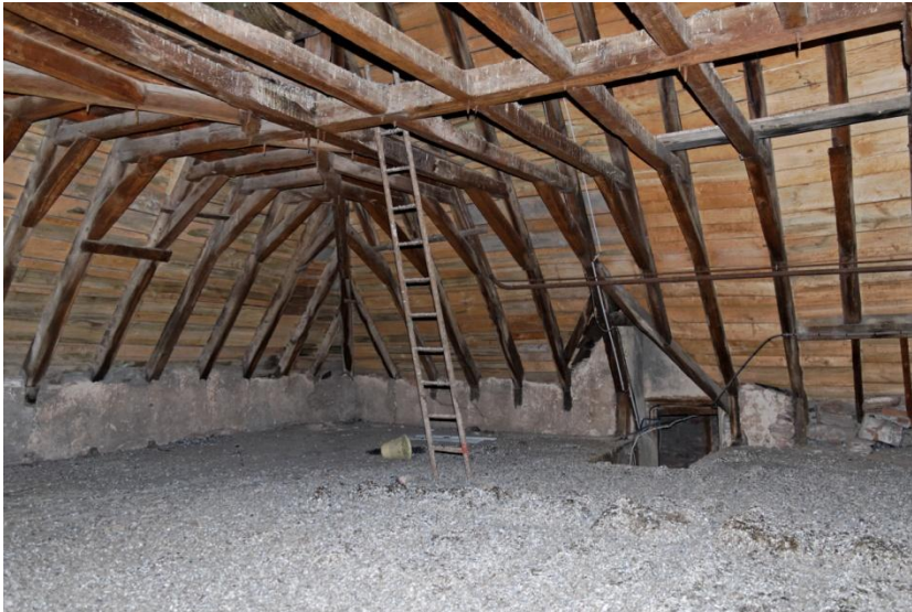
La charpente du pavillon sud-est.
