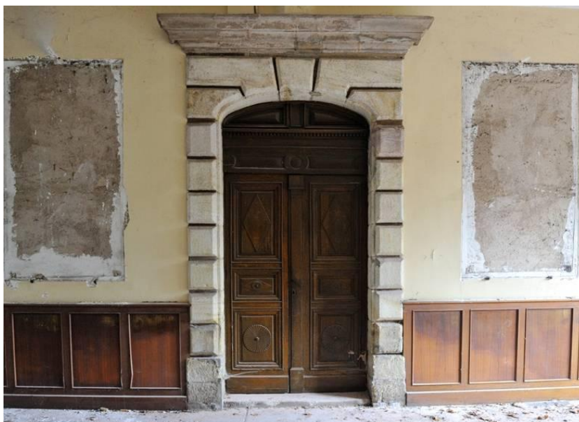
La porte principale de la chapelle sur le passage couvert de l'entrée principale.
