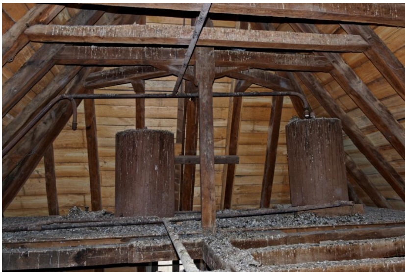
La charpente du pavillon sud-est, niveau du pignon au-dessus des entrails retroussés.
