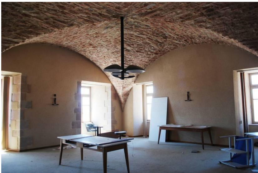
Le rez-de-chaussée du pavillon sud-ouest.
