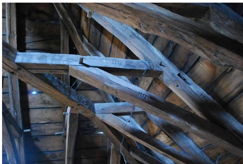
Détail des marques d'assemblages de la charpente du pavillon sud-ouest.
