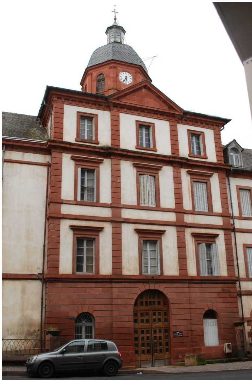
Le pavillon d'entrée sur la rue Combarel, au centre de l'aile nord.
