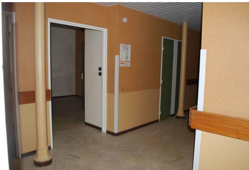
Une pièce du premier étage de l'aile nord ; les colonnes en fontes montrent que la salle était dépourvue de cloisons à la fin du XIXe siècle.
