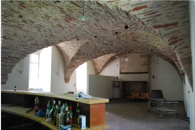
Le rez-de-chaussée de l'aile est.
