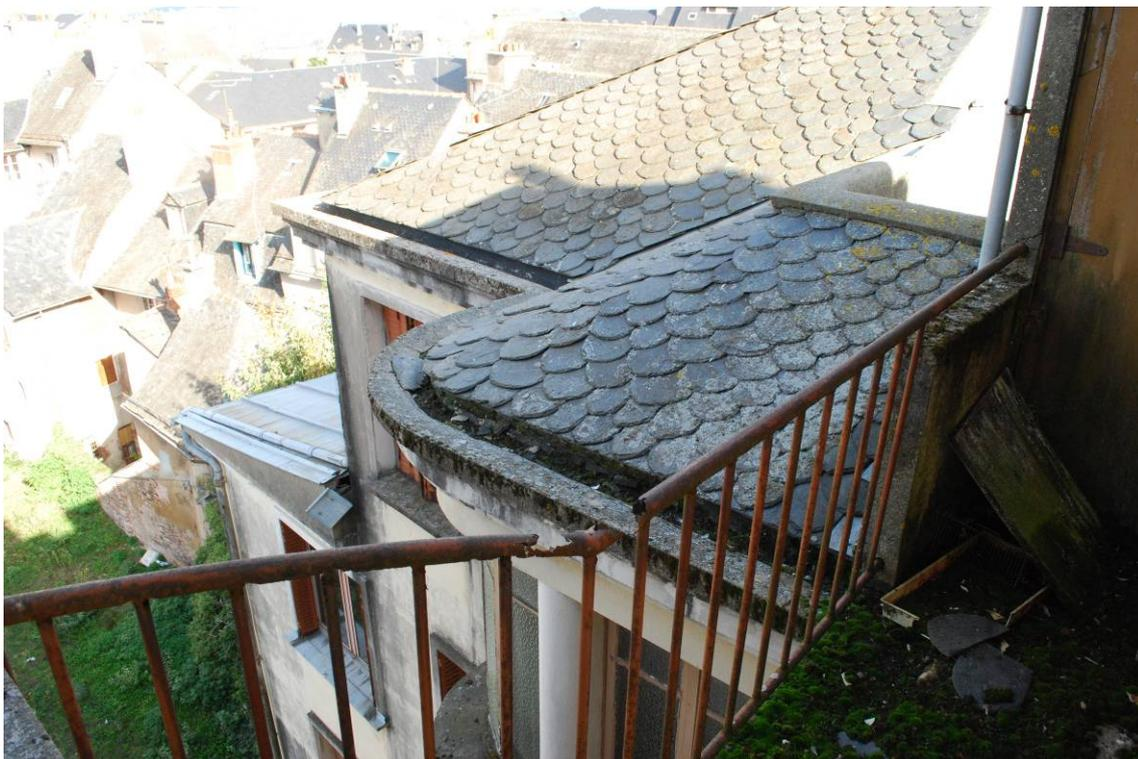
Figure 16 : Détail de la couverture et des chéneaux au nord.
