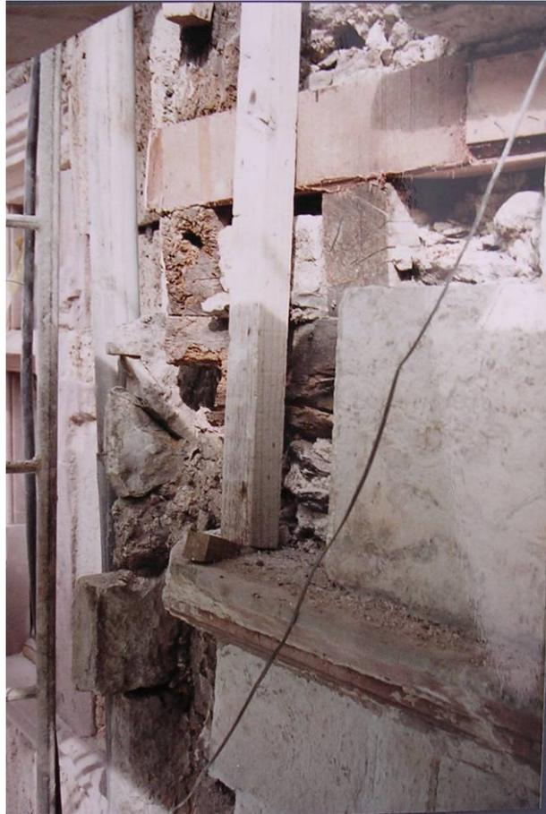
Figure 24 : Placage de calcaire sur une structure à pan de bois, cliché Vermorel, 1991.
