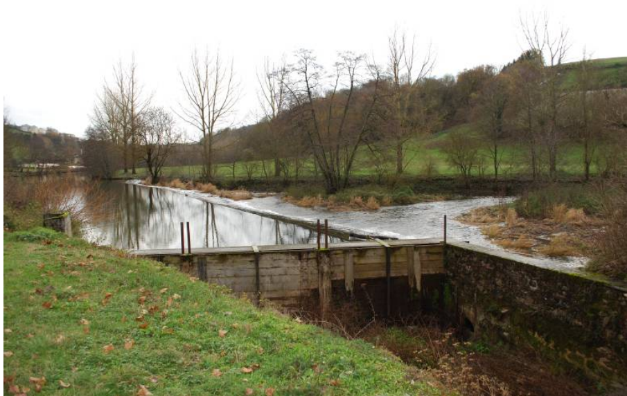
Figure 9 : Vue de l'Aveyron en amont du moulin : le barrage sur l'Aveyron et le canal d'amenée, fermé, alimentant le moulin.
