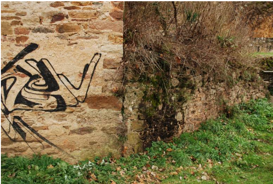
Figure 13 : Bec maçonné de renforcement de la façade du moulin vers l'amont (construit a posteriori contre la façade).
