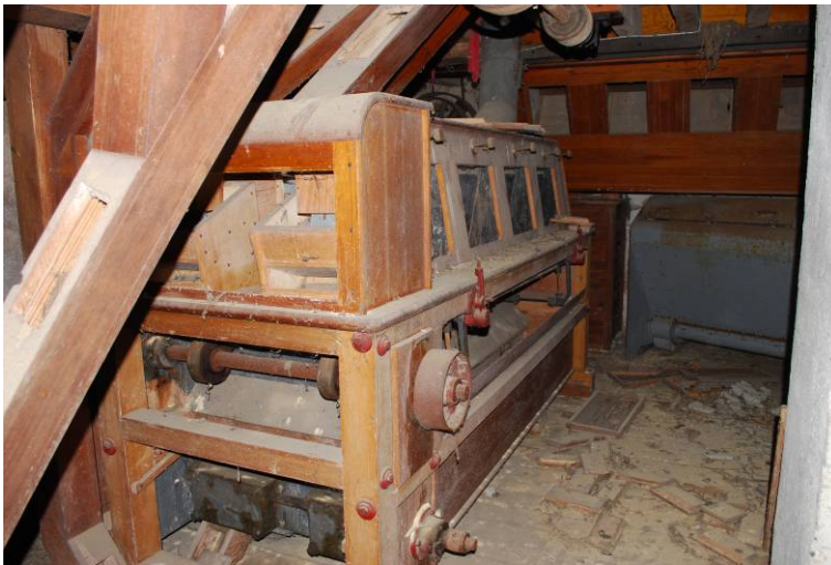
Figure 23 : Premier étage, le sasseur, qui effectue un criblage par courant d'air et le système en bois de l'élevateur.
