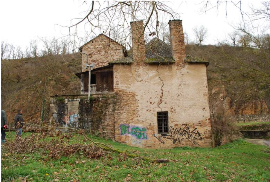
Figure 12 : Elévation sud-ouest du moulin.
