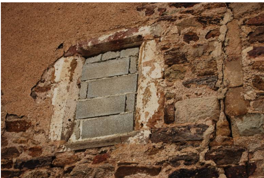
Figure 14 : Façade du moulin vert l'amont, fenêtre bouchée de l'étage à encadrement chanfreiné et appui saillant bûché, première moitié du XVI e siècle.
