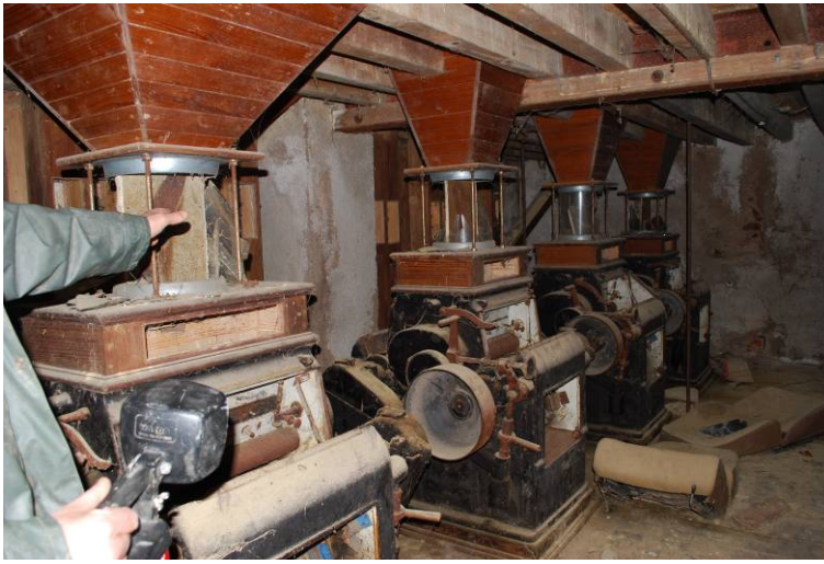
Figure 21 : Premier étage, les machines à cylindres pour broyer le grain.
