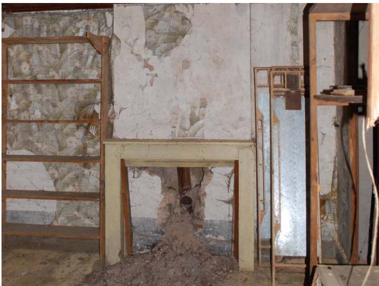
Figure 24 : Premier étage, la cheminée d'une pièce du logis du meunier.
